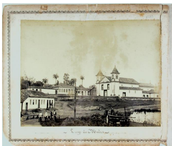
Figura 2; [CC.ALB.01-022]: Reprodução fotográfica do Largo da Igreja Matriz de Nossa Senhora da Boa Viagem em 1894. Esta região era o principal espaço comercial e de convívio social, cultural e religioso do Arraial. Cabe ressaltar que esta Igreja foi totalmente demolida em meados da década de 1930, para ceder
