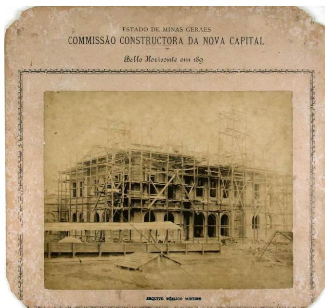
Figura 11; [SA2 004 003]: Reprodução fotográfica da construção do edifício que sedea da Secretaria da Agricultura. Esta imagem de outubro de 1896, e apresenta uma fase intermediária da construção do prédio, que tem o autor do seu projeto o arquiteto José de Magalhães. Acervo: Arquivo Público Mineiro.
