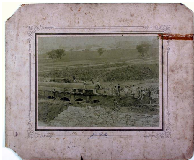
Figura 11; [CCFot1896-005]: Reprodução fotográfica de trabalhos de construção de tubulação hidráulica em frente aos galpões da Comissão Construtora, região próxima ao Parque Municipal. Acervo: Arquivo Público Mineiro.
