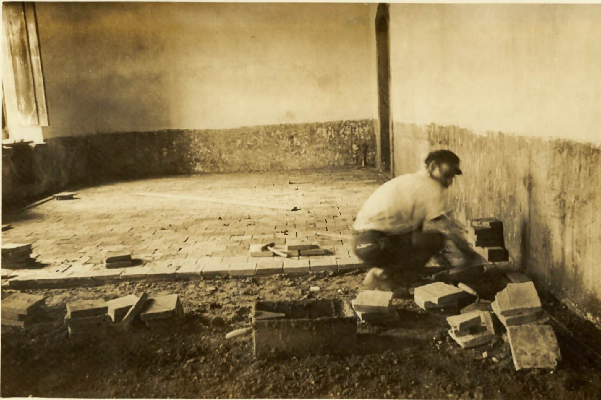
Figura 15 - Obras na Igreja do Rosário. Fonte: Documentação Permanente Série 01 - Igreja de Nossa Senhora do Rosário (IPHAN-MG).
