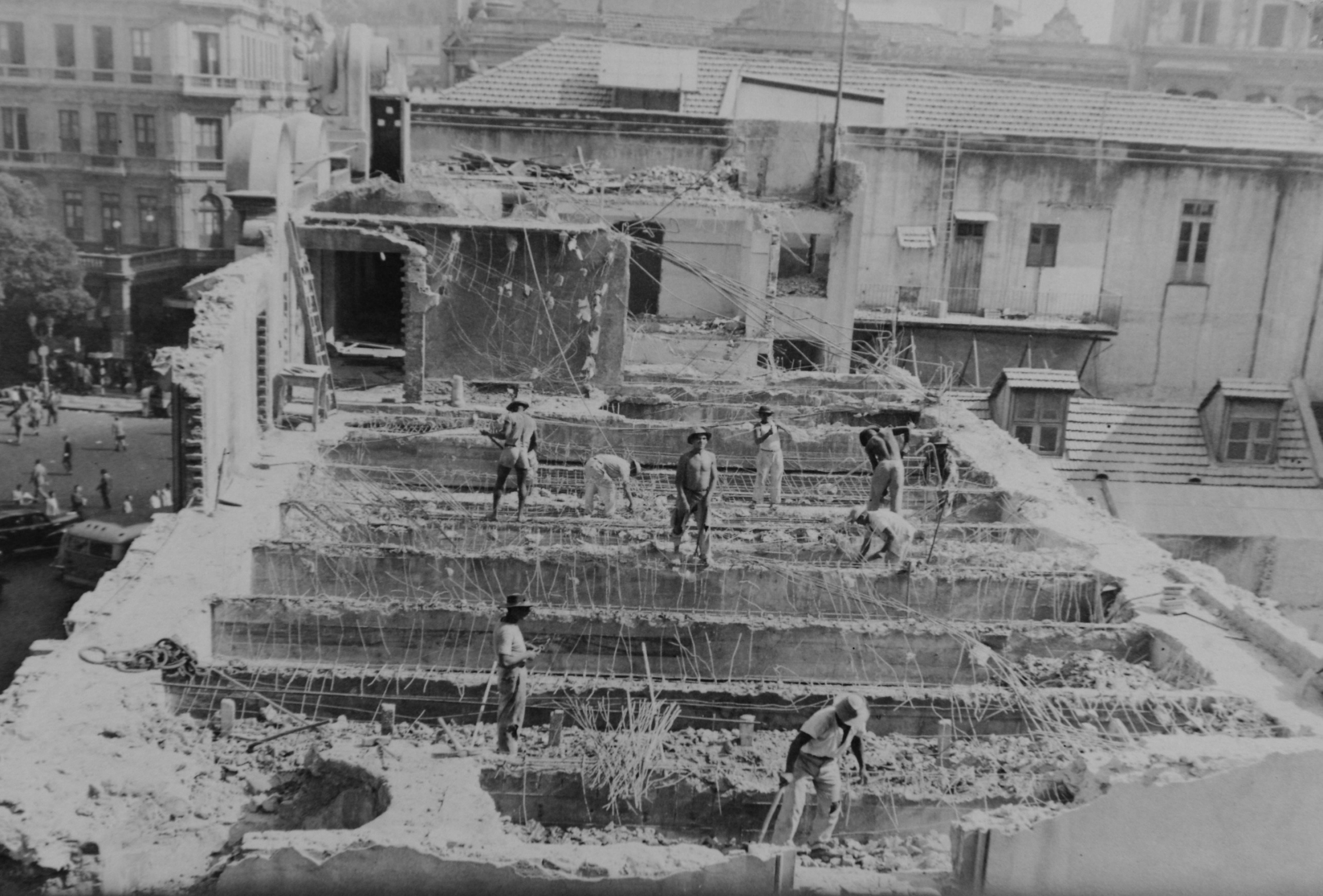
Figura 39 - Demolição da Igreja do Parto. Fonte: Arquivo Geral da Cidade do Rio de Janeiro.
