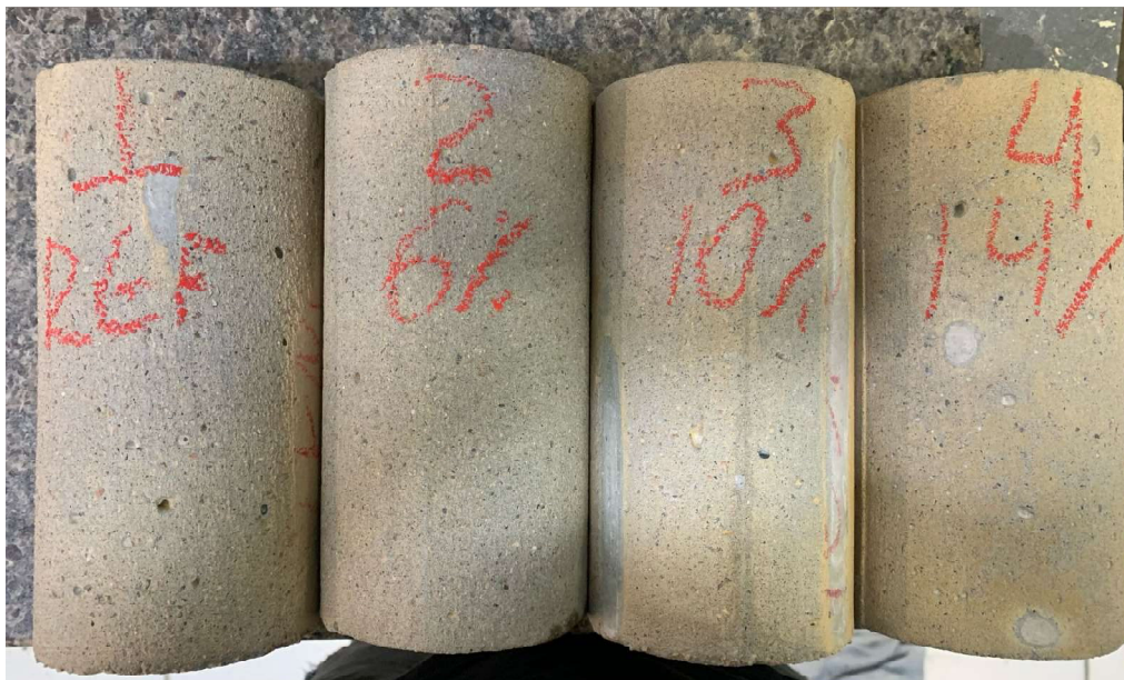
Figura 23 – Deterioração superficial do concreto após o ataque ácido
