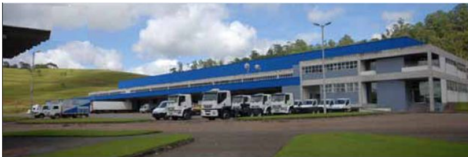
FIGURA 7.2: Armazém logístico – SGO [SGO, 2010]
