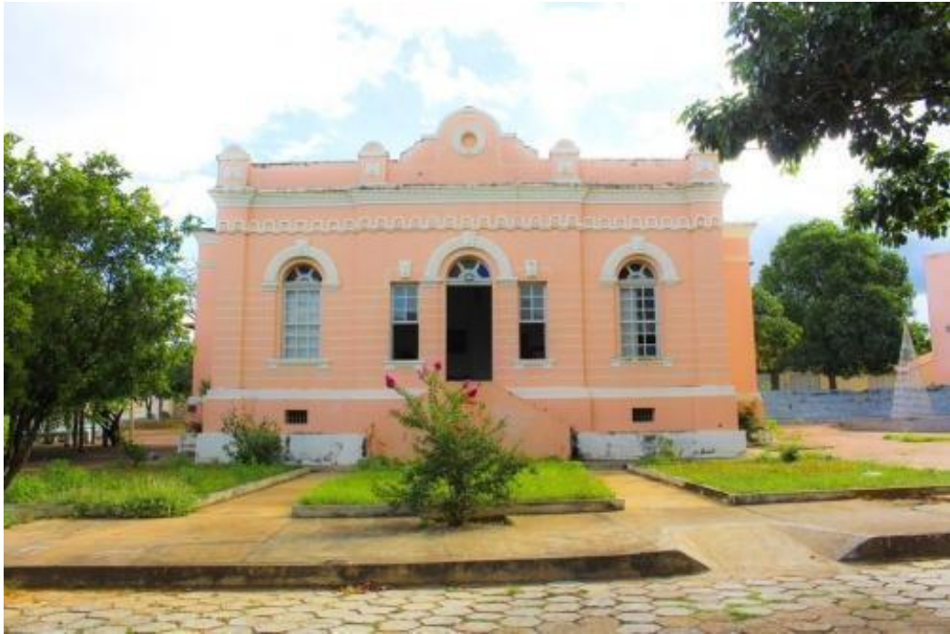
Foto 7 – Fundação de cultura de Salinas/antigo presídio da cidade
