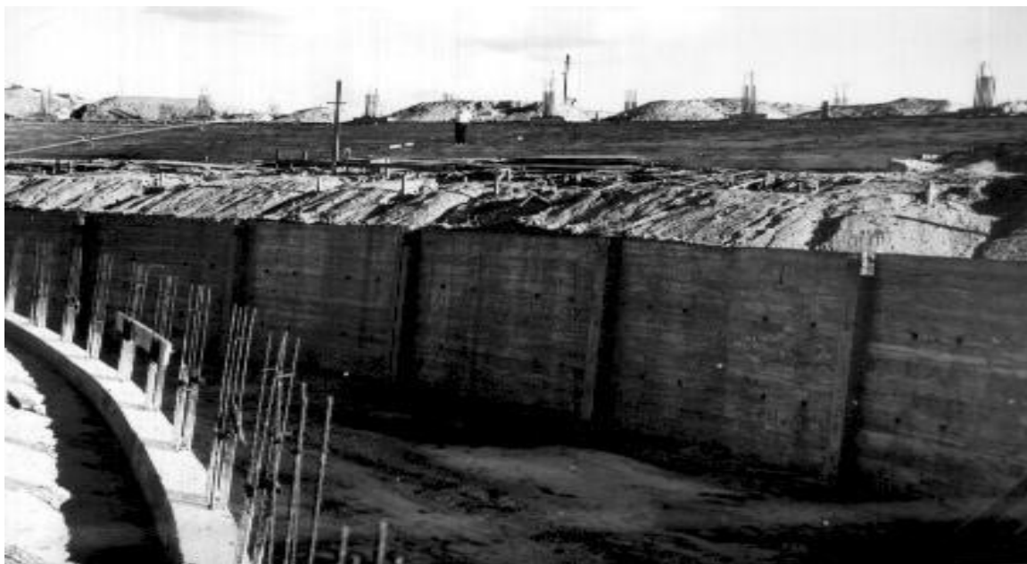
Figura 9 - Fundações do Estádio
