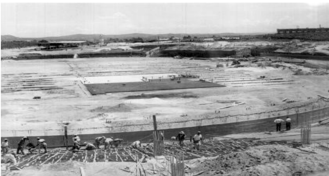
Figura 10 - Obras de construção do Estádio “Mineirão”
