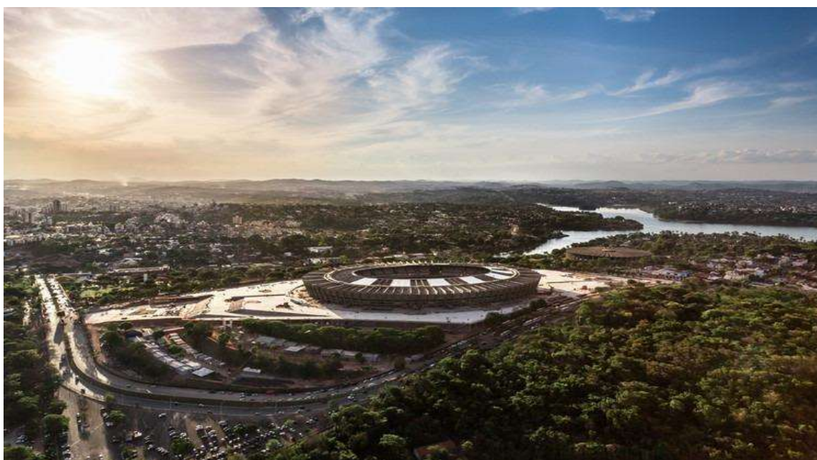
Figura 7- Vista aérea do Mineirão em obras (2012)
