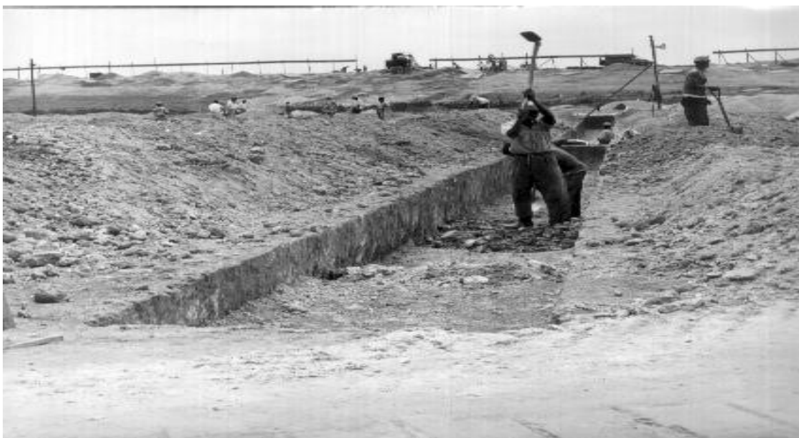
Figura 8 - Escavação das Fundações do Estádio
