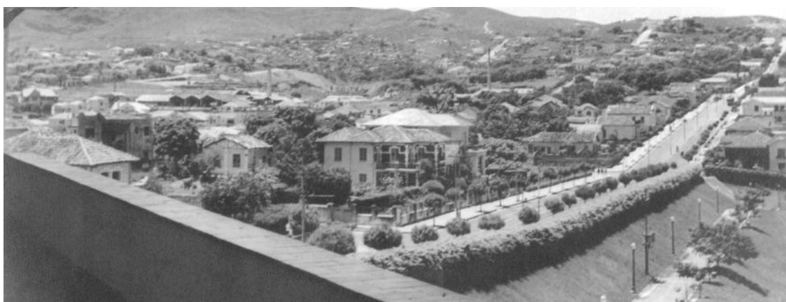
FIGURA 34: Fotografia da Rua da Bahia 1930-40, vista do balcão do Minas Tênis Clube.
