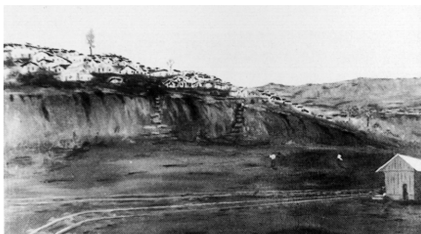
FIGURA 51: Desnível no contato entre a várzea e as colinas do Arrudas, 1896.
