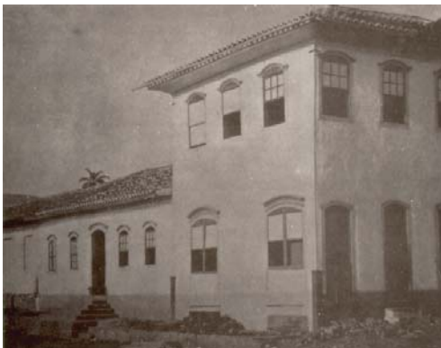
FIGURA 9: Sobrado em que se instalou a Comissão Construtora, na Rua Marechal Deodoro, s.d.
