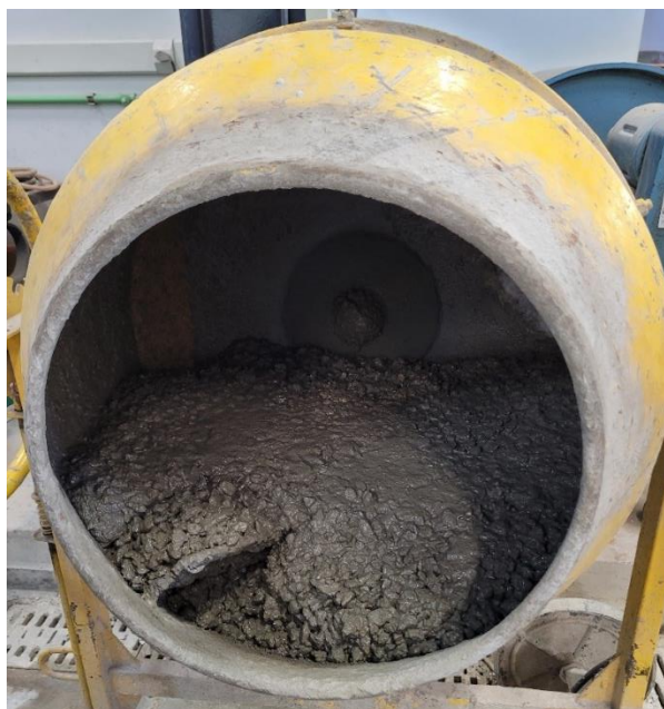
Figura 15: Mistura dos materiais na betoneira
