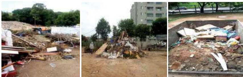
Figura 4 – aspectos típicos das URPV de Belo Horizonte – a) acúmulo de grandes quantidades de materiais variados, misturados e espalhados, expostos às intempéries; b) acúmulo de material no solo, dificultando carregamento e remoção (obrigando a muito trabalho manual); c) colocação indiferenciada de RS nas caçambas (poderia haver triagem nas URPV), resultado da falta de cooperação dos usuários
