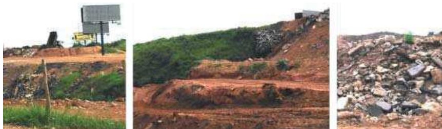
Figura 11 – aspectos do bota-fora localizado na cidade de Vespasiano
