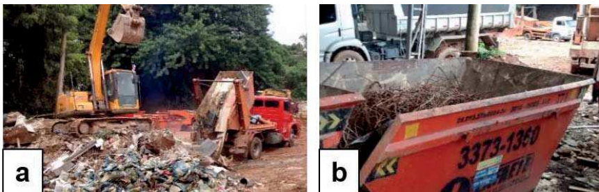
Figura 10 – (a) pátio e operação de uma ATT de grande porte em Belo Horizonte; (b) caçambas de armazenamento temporário do material triado
