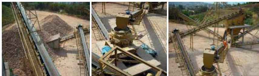
Figura 7 – vistas da estação de reciclagem de entulho da BR-040 em Belo Horizonte
