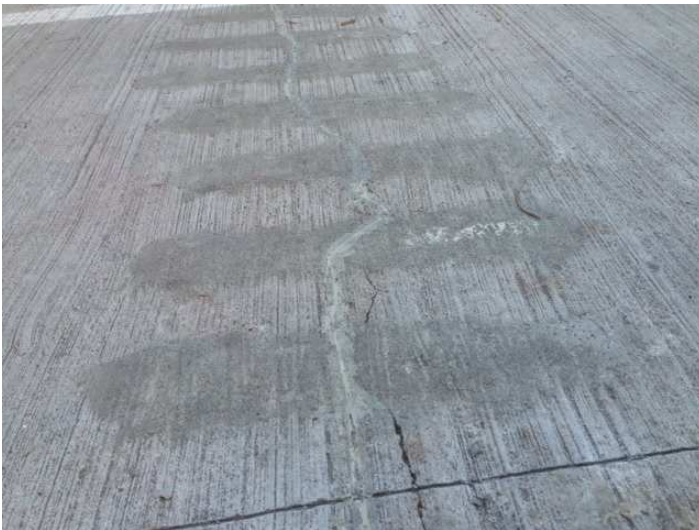
Figura 21. Estado do reparo de inserção de barras corrugadas (aço CA 50).
