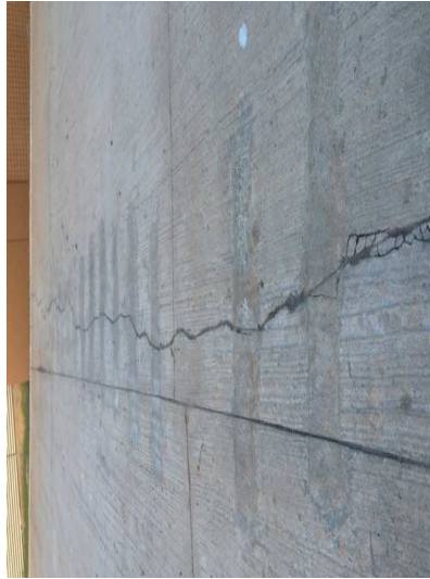
Figura 22. Estado do reparo de inserção de barras lisas (CA25).
