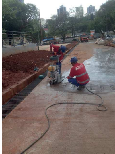
Figura 11. Corte das valas com serra clipper.
