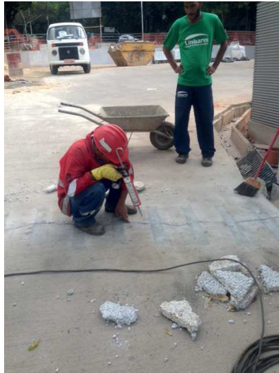
Figura 16. Preenchimento da fissura com poliuretano.
