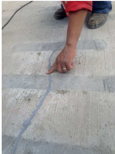
Figura 17. Reparo finalizado e acabado.
