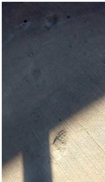
Figura 10. Pegadas no pavimento.
