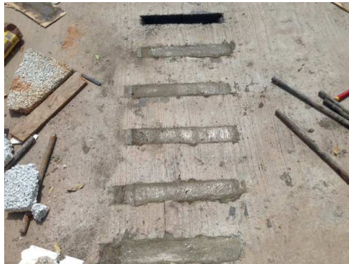
Figura 15. Preenchimento das valas com graute.
