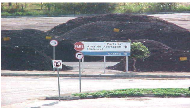
Figura 17 – Leiras no pátio impermeabilizado da unidade de compostagem no CTRS/BR-040
