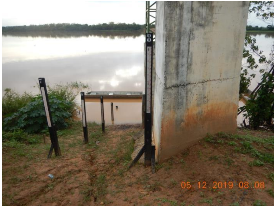
Figura 2.3 – Réguas instaladas na estação São Romão – Rio São Francisco
