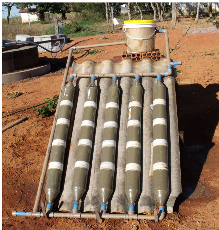
FIGURA 5 - Sistema de Tratamento por Radiação Ultravioleta – Efluente. Fonte: Da autora.
