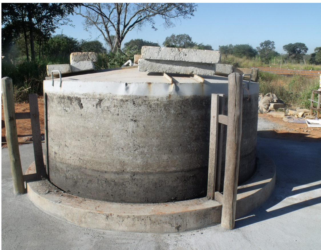
FIGURA 4 – Biodigestor Modelo Indiano. Fonte: Da autora.
