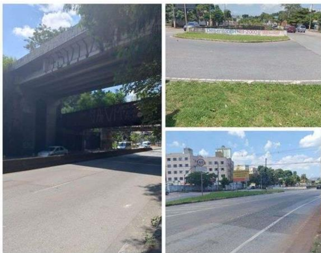
Figura 52 - Canal fechado e canalizado no ribeirão
