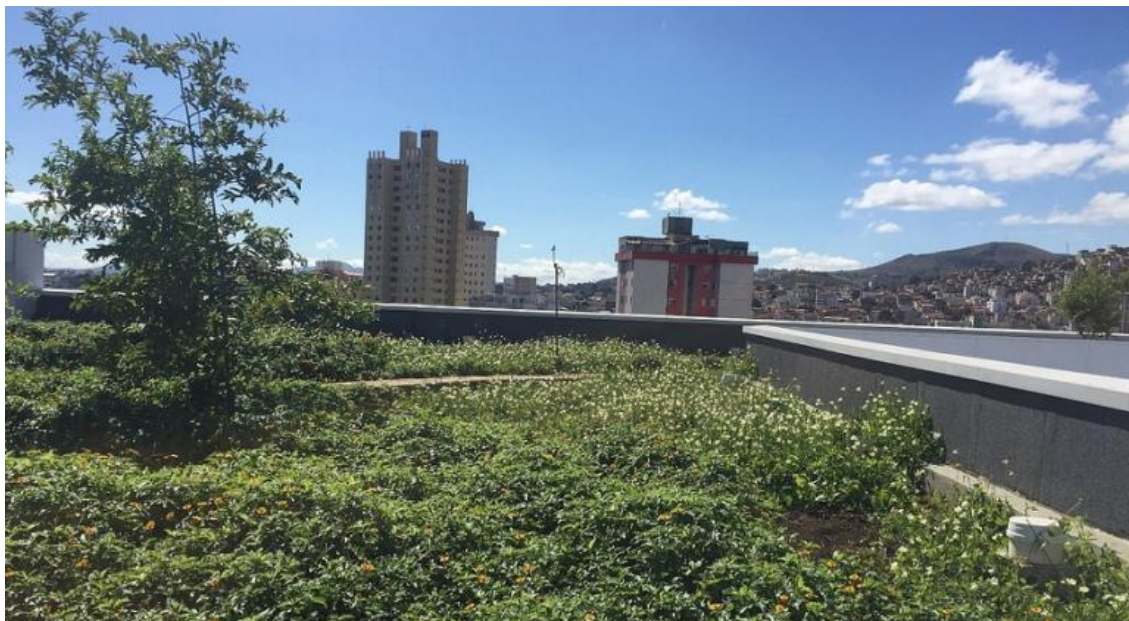
Figura 16 - Telhado verde com vegetação forrageira na cidade de Belo Horizonte
