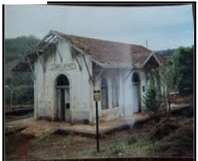
Foto 03: Antiga escola do Distrito de Lobo Leite
