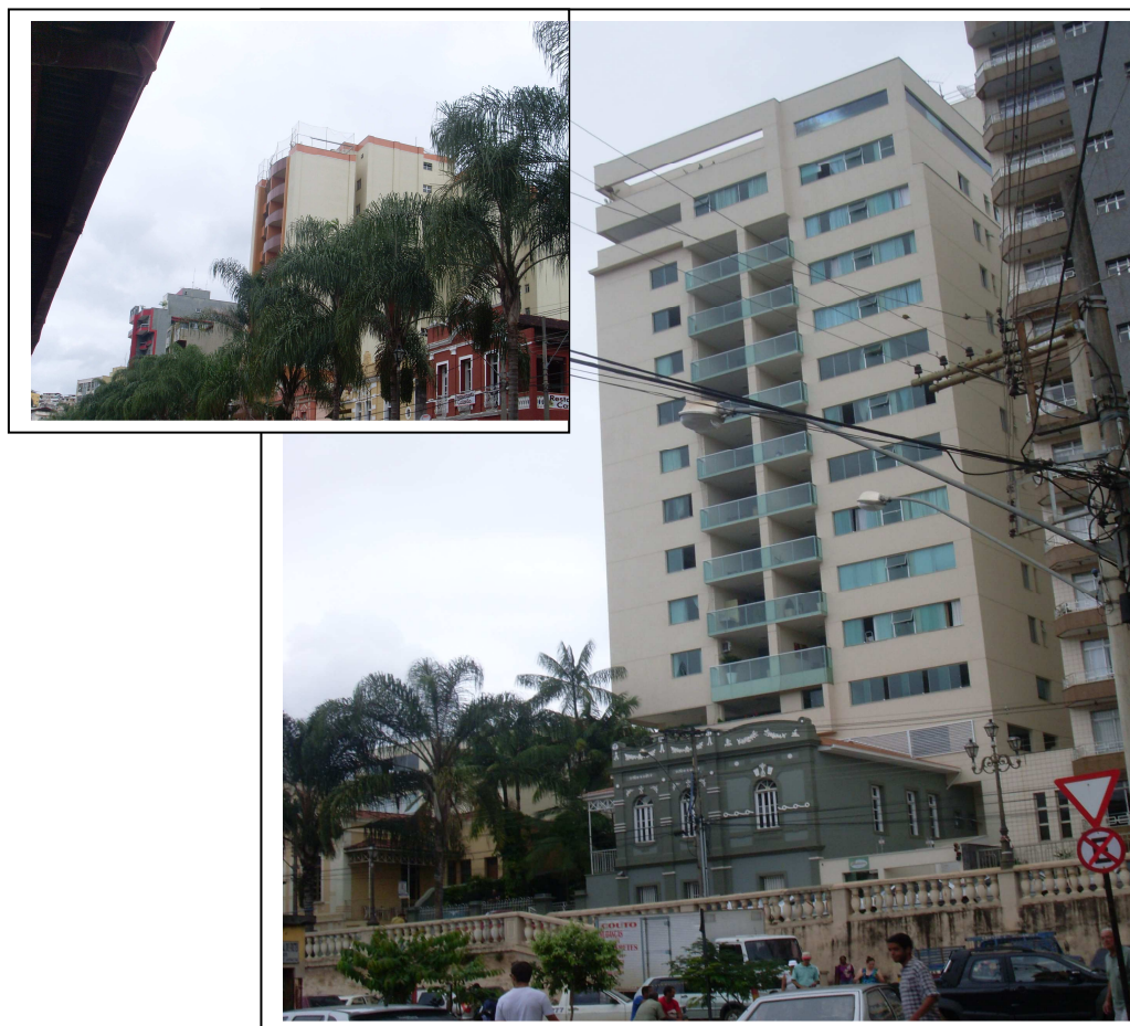
Figura 16 – Edifício Cora Bolívar localizado no Balaústre, Viçosa MG
