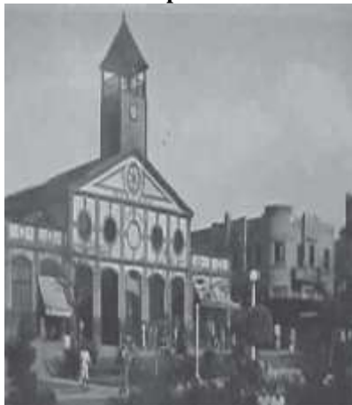
Figura 4 – Antigo Mercado Municipal com a torre e o regulador público.
