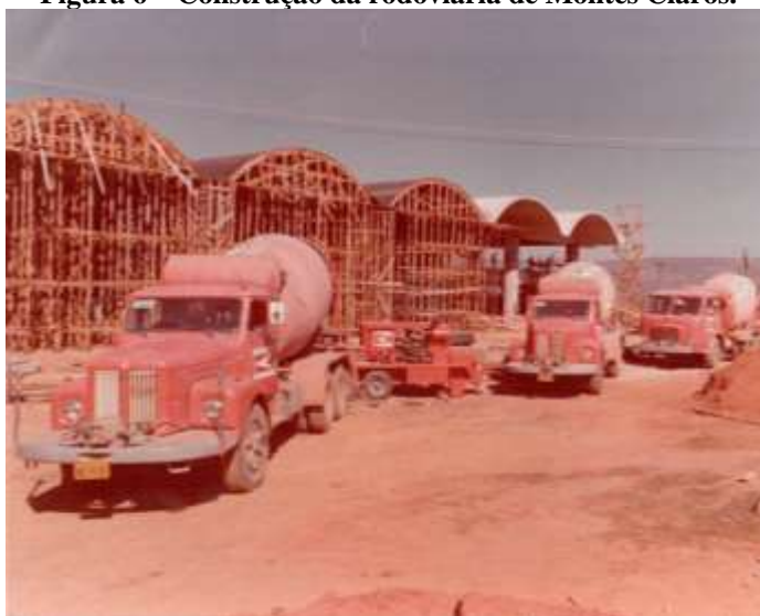
Figura 6 – Construção da rodoviária de Montes Claros.
