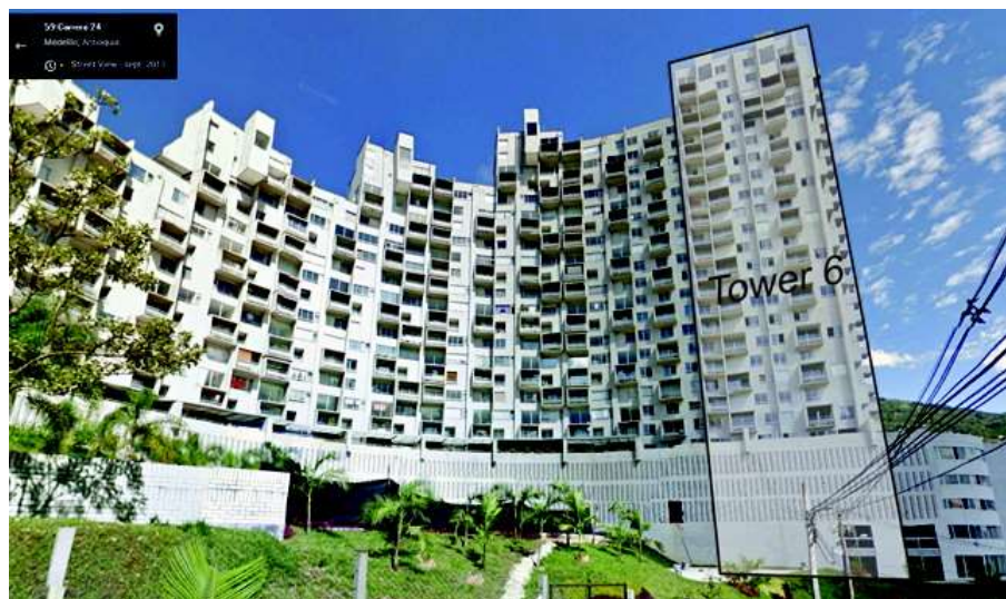
(a) Poucos dias antes do colapso.
