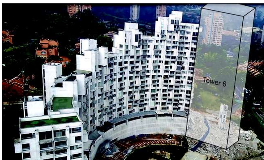
(b) Poucos dias após o colapso.
