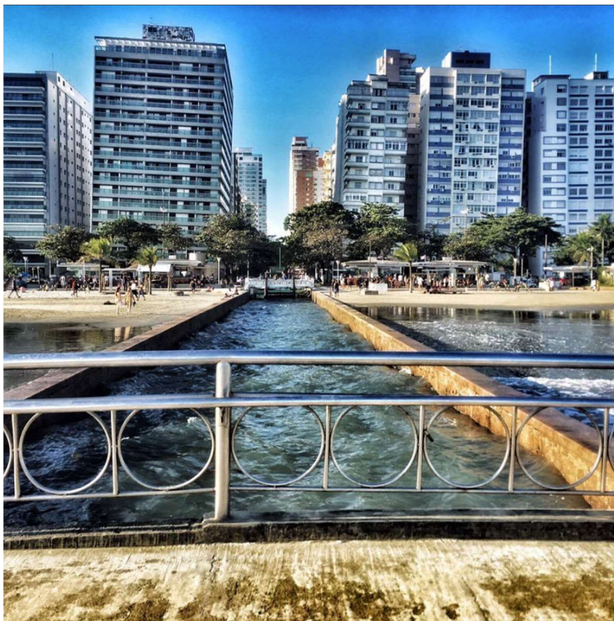
Figura 1.4 – Edifícios inclinados na cidade de Santos - SP. Fonte: BLOGSPOT ORGULHO DE SER PAULSTA, 2017.
