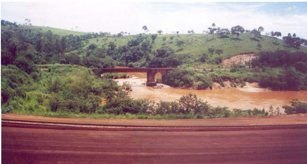
FIGURA III.4 - Na parte superior, cenário de jusante da ponte (Rio Macaubas). Abaixo, cenário do Ponto de Controle – PC2, Alberto Flores, a montante da sede urbana de Brumadinho.
