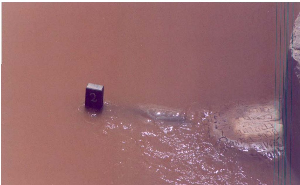
FIGURA III.15 - Ponto de Controle – PC4: Detalhe de componente da estrutura de medição de vazão, com lâmina d’água próximo à marcação “2”.
