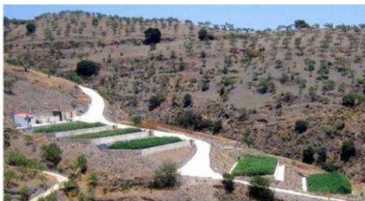
Figura 3.5: SAC do tipo francês construído em Albadón, Espanha, com três leitos no primeiro estágio tratando esgotos brutos e dois no segundo estágio para pós-tratamento.
