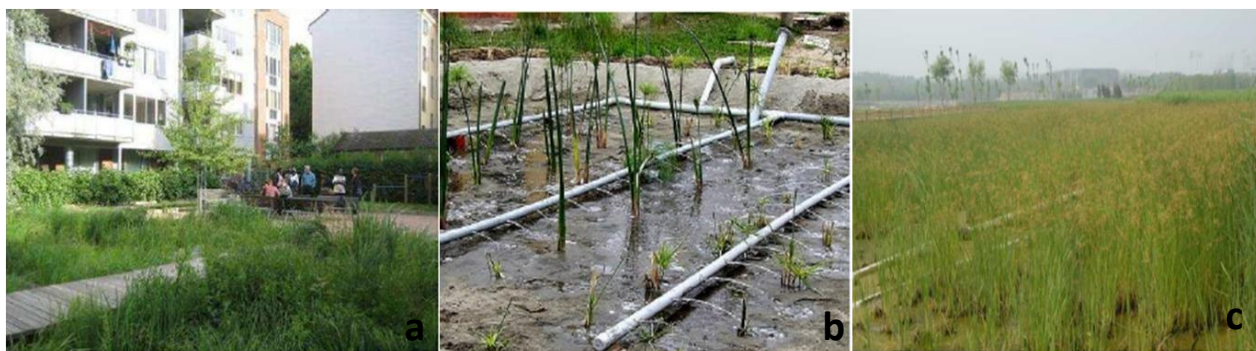
Figura 3.1: Exemplos da aplicação de SAC no mundo. (a) tratamento de água cinza em área urbana com SAC subsuperficial em Oslo, Noruega (Foto: L. Urich, 2008); (b) SACV em construção durante o teste de uniformidade de distribuição em Lima, Peru (Foto: H. Hoffmann, 2008); (c) SACV tratando esgoto doméstico no Olympic Forest Park em Pequim, China (Foto: L. Germer, 2008).
