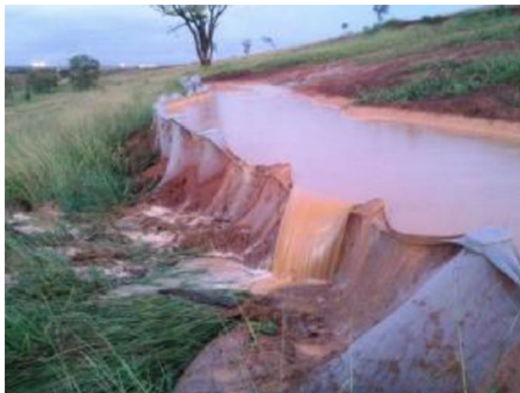
Figura 36 – Barreira de contenção geotextil Fonte: Empresa Novva Solutions
