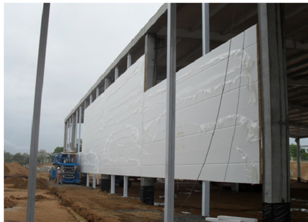
Figura 21 – Painel Isotérmico sendo instalado em uma obra Fonte: Site da empresa Isoeste.
