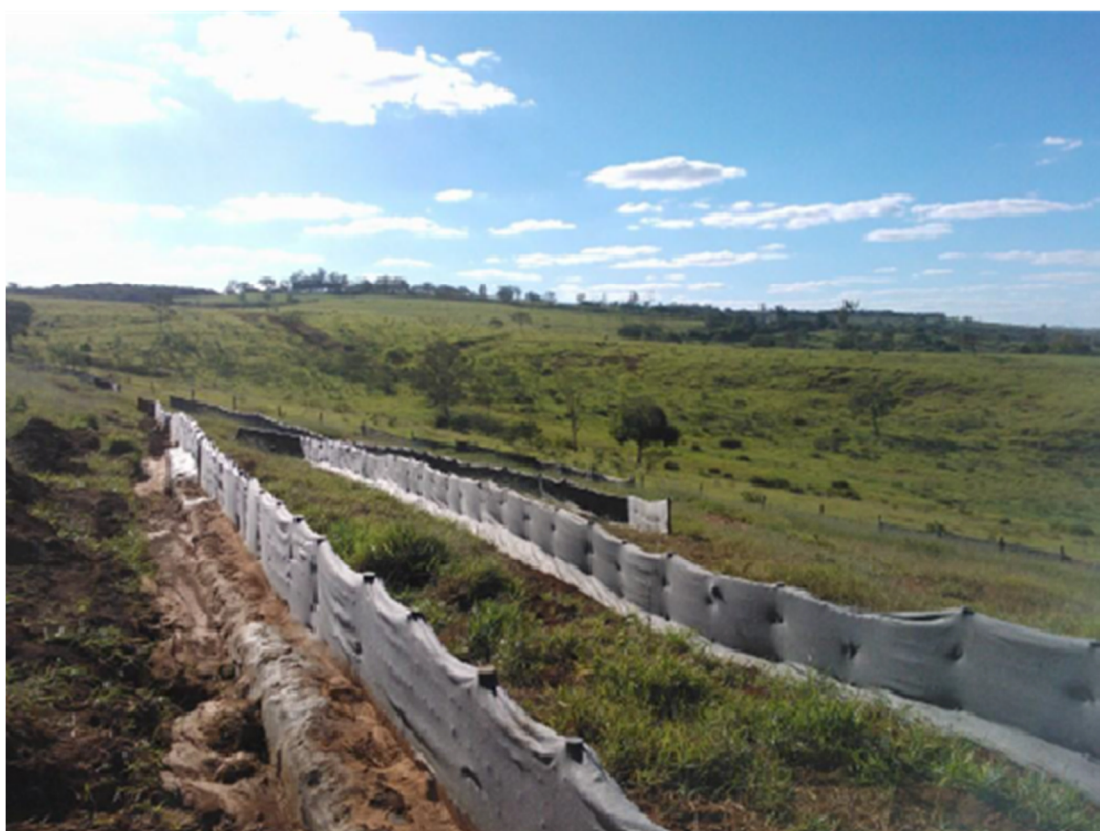
Figura 37 – Barreira de contenção geotêxtil corrigida Fonte: Empresa Nova Solutions
