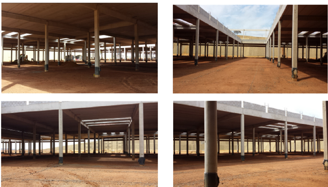
Figura 28, 29, 30 e 31 – Organização e Limpeza do canteiro de obra Fonte: Empresa Henrique & Henrique Engenharia Ltda.
