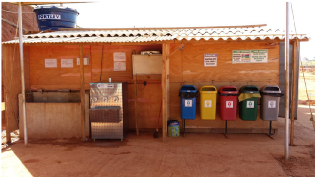
Figura 23 – Separação dos resíduos gerados pelos usuários da obra Fonte: Empresa Henrique & Henrique Engenharia Ltda.
