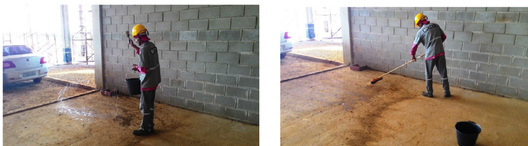
Figura 32, 33 – Organização e Limpeza do canteiro de obra Fonte: Empresa Henrique & Henrique Engenharia Ltda.
