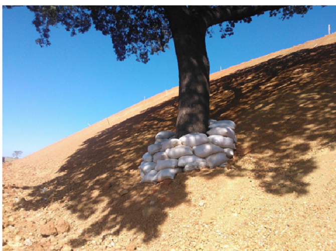
Figura 39 – Proteção da vegetação existente Fonte: Empresa Novva Solutions
