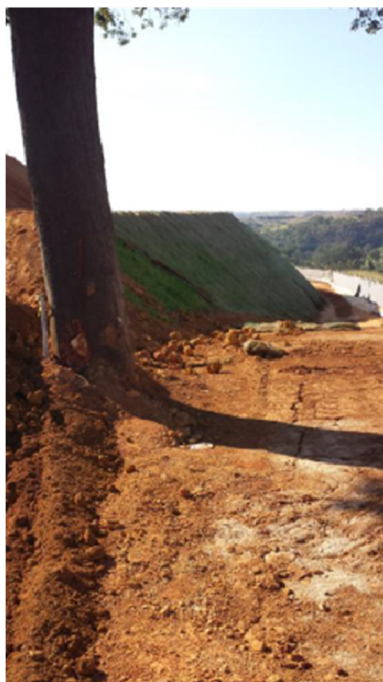
Figura 38 – Proteção da vegetação existente Fonte: Empresa Novva Solutions
