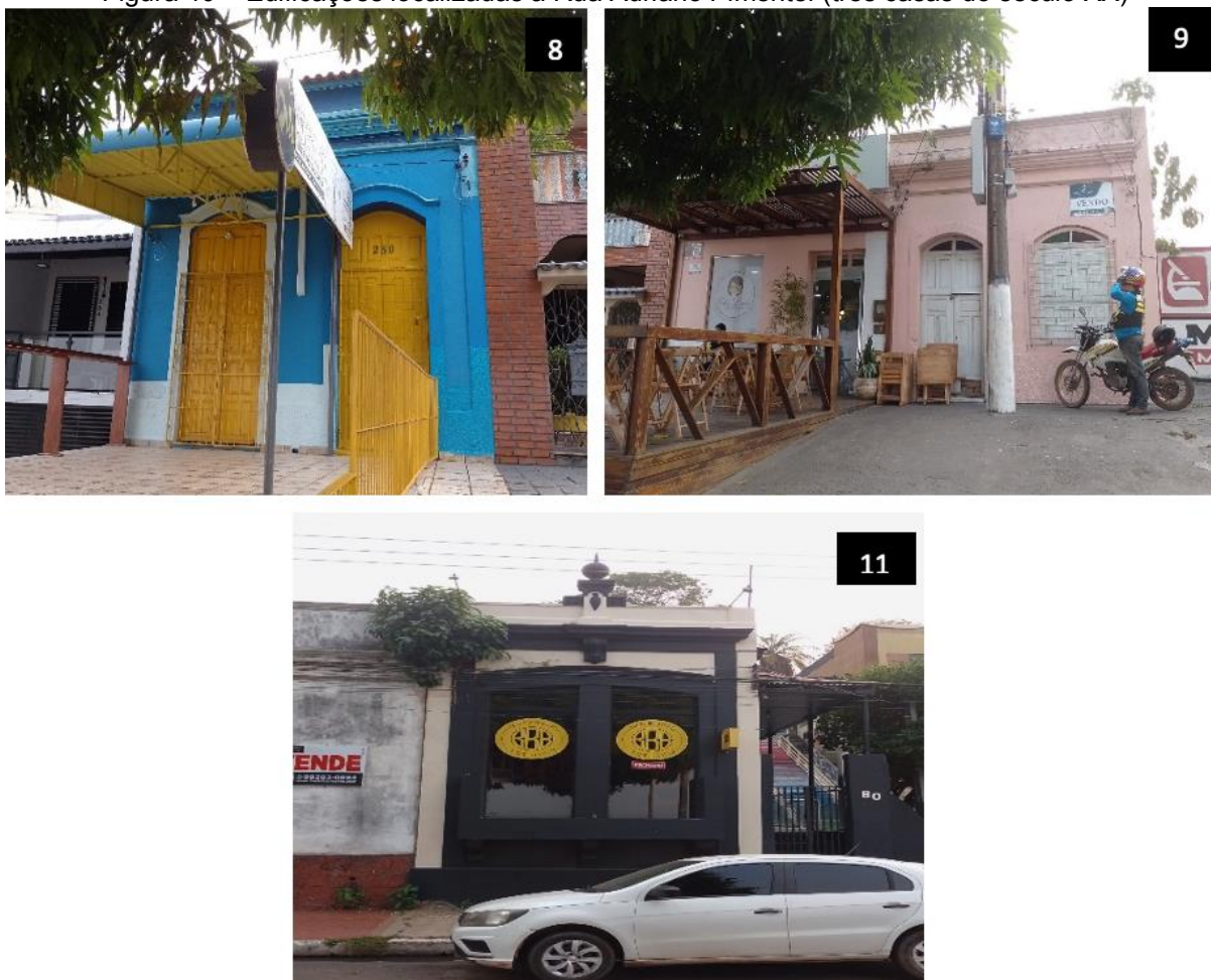
Figura 40 – Edificações localizadas a Rua Adriano Pimentel (três casas do século XX)
