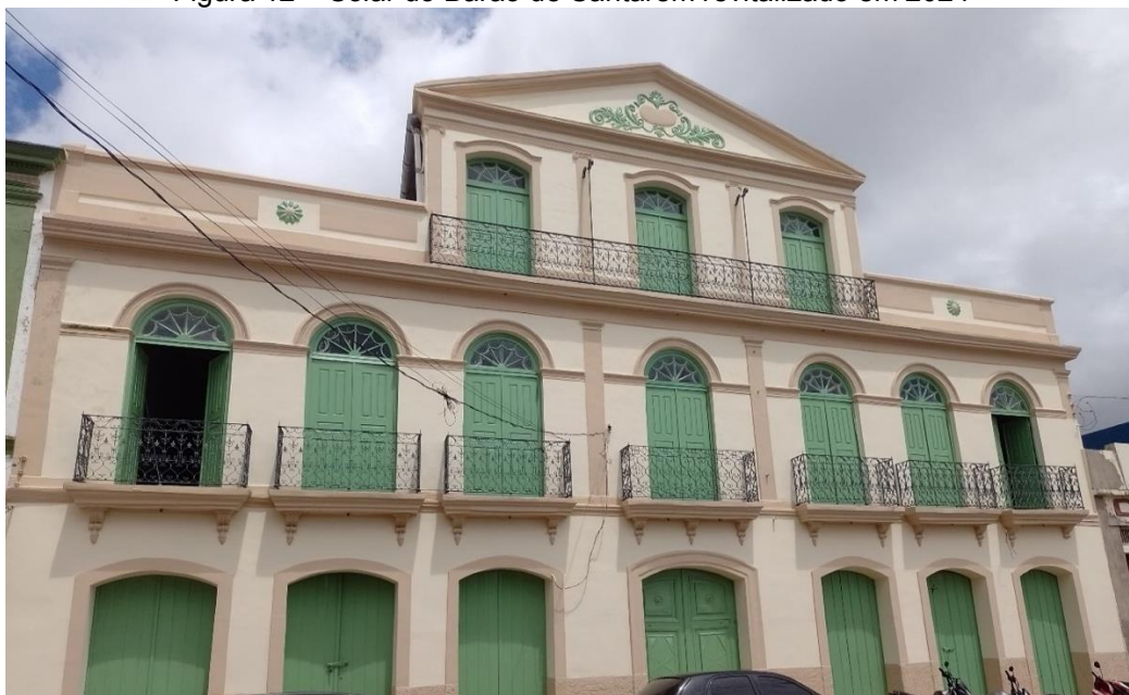
Figura 12 – Solar do Barão de Santarém revitalizado em 2024
