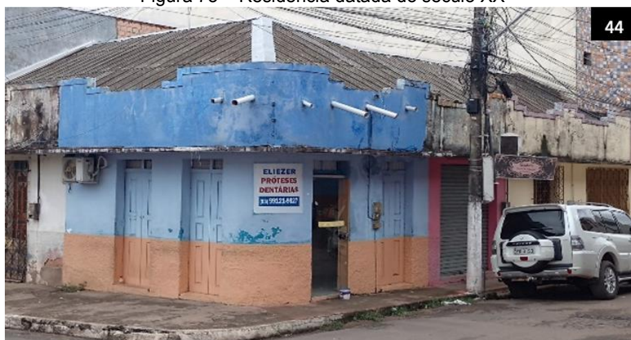
Figura 73 – Residência datada do século XX
