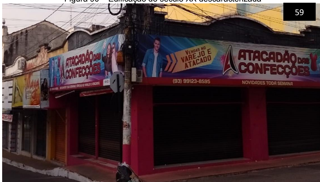
Figura 90 – Edificação do século XX descaracterizada
