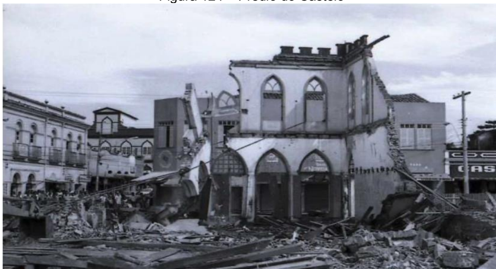
Figura 124 – Prédio do Castelo
