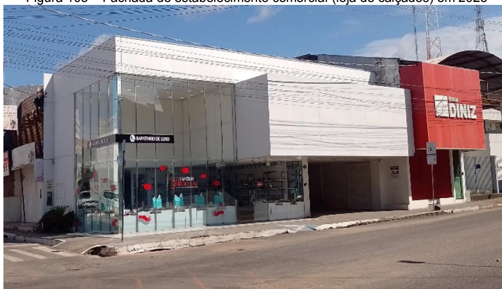
Figura 103 – Fachada de estabelecimento comercial (loja de calçados) em 2025
