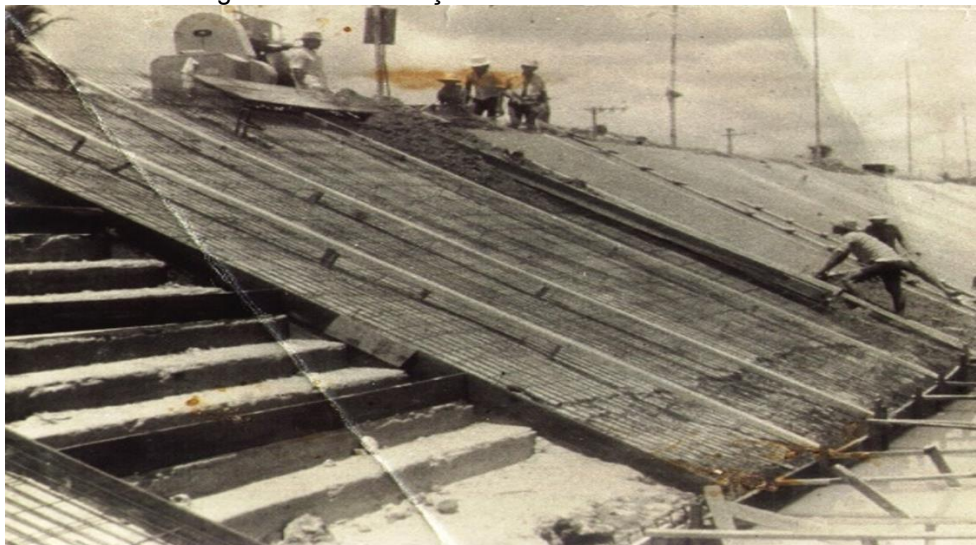
Figura 21 – Construção do Cais de arrimo em 1977
