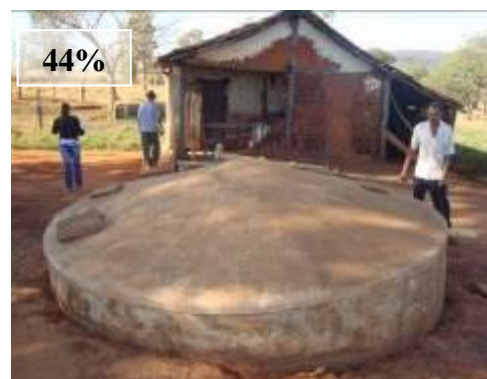
FIGURA 4.54: Cisterna com condição de pintura ruim. Município de Capitão Enéas, Norte de Minas – UGM CAA Ano de construção da cisterna: 2007
