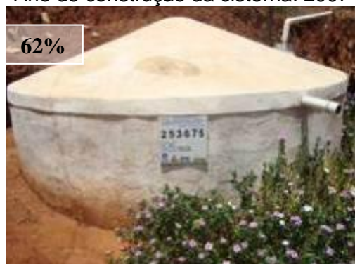
FIGURA 4.57: Cisterna com condição de pintura boa. Município de Berilo, Vale do Jequitinhonha – UGM CAV Ano de construção da cisterna: 2007
