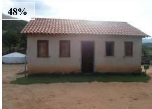
FIGURA 4.31: Domicílio com cobertura em condição boa. Município de Mamonas, Norte de Minas – UGM CAA. Tempo de residência: 26 anos.
