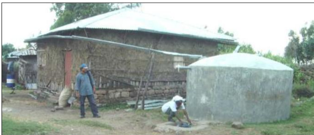
FIGURA 4.2: Cisterna para armazenamento de água de chuva da Etiópia.
