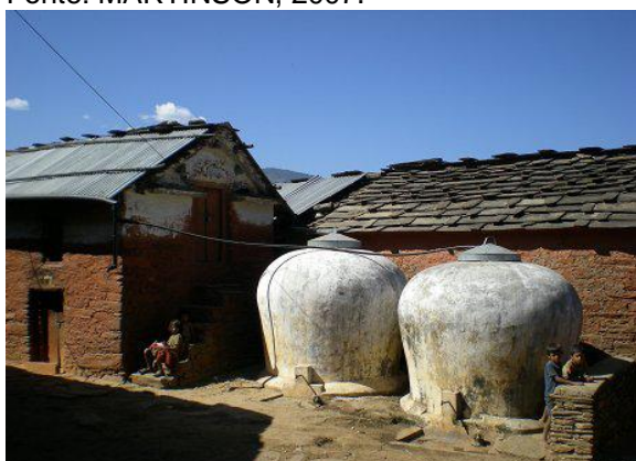
FIGURA 4.3: Cisterna para armazenamento de água de chuva ( 6,5\text{m}^3 ) no Nepal.
