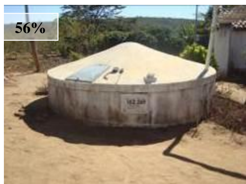
FIGURA 4.53: Cisterna com condição de pintura boa. Município de São João do Paraíso, Norte de Minas – UGM CAA Ano de construção da cisterna: 2006
