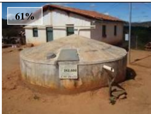
FIGURA 4.25: Domicílio com estrutura em condição boa. Município de Novorizonte, Norte de Minas – UGM CAA Tempo de residência: 30 anos
