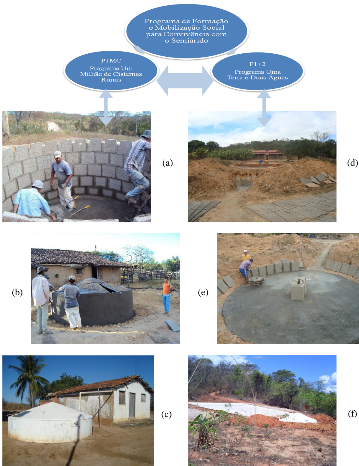
FIGURA 4.40: Etapas do P1MC. (a) e (b) construção de cisternas de placa no município de Serranópolis de Minas, mesorregião Norte de Minas. (c) Cisterna de placa município de Matias Cardoso, mesorregião Norte de Minas, semiárido mineiro.
