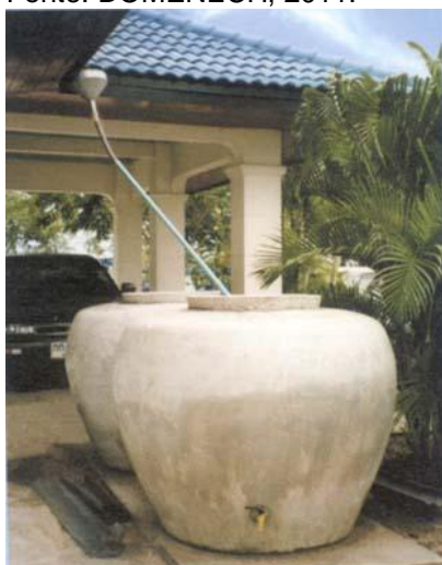
FIGURA 4.5: Cisterna para armazenamento de água de chuva ( 2\text{m}^3 ) na Tailândia.
