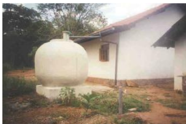
FIGURA 4.4: Cisterna para armazenamento de água de chuva ( 5\text{m}^3 ) no Sri Lanka.
