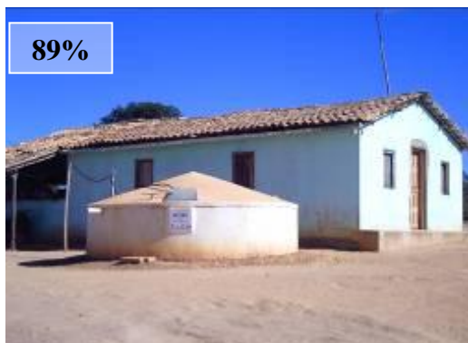
FIGURA 4.59: Cisterna com condição de entorno boa. Município de Indaiabira, Norte de Minas – UGM CAA. Ano de construção da cisterna: 2009
