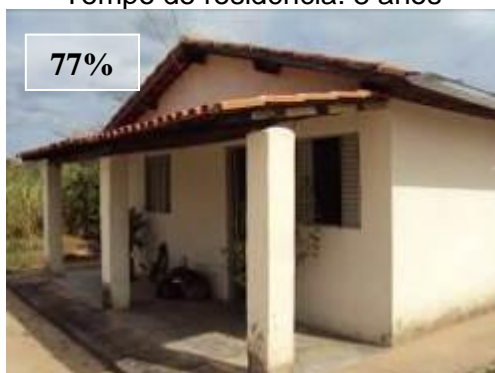
FIGURA 4.29: Domicílio com estrutura em condição boa. Município de Coronel Murta, Vale do Jequitinhonha – UGM CAV. Tempo de residência: 6 anos.
