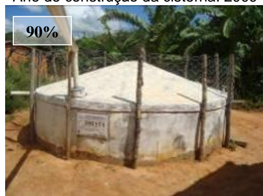
FIGURA 4.61: Cisterna com condição de entorno boa. Município de Pedras de Maria da Cruz, Norte de Minas – UGM CAR. Ano de construção da cisterna: 2008
