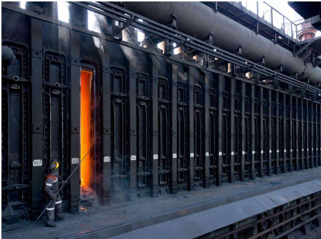
FIGURA 3.5: Bateria de Coque
