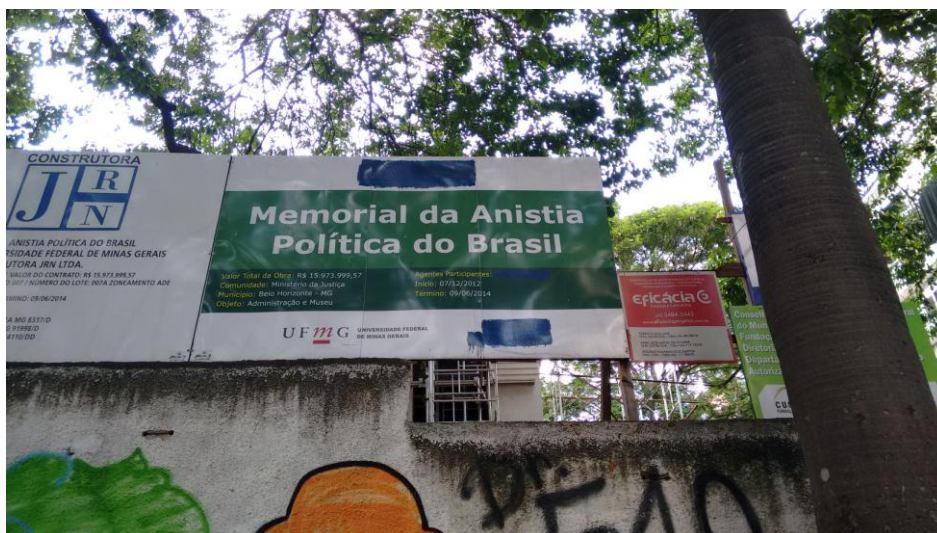
Figura 69 – Placa com a previsão de término da obra para 09/06/2014
