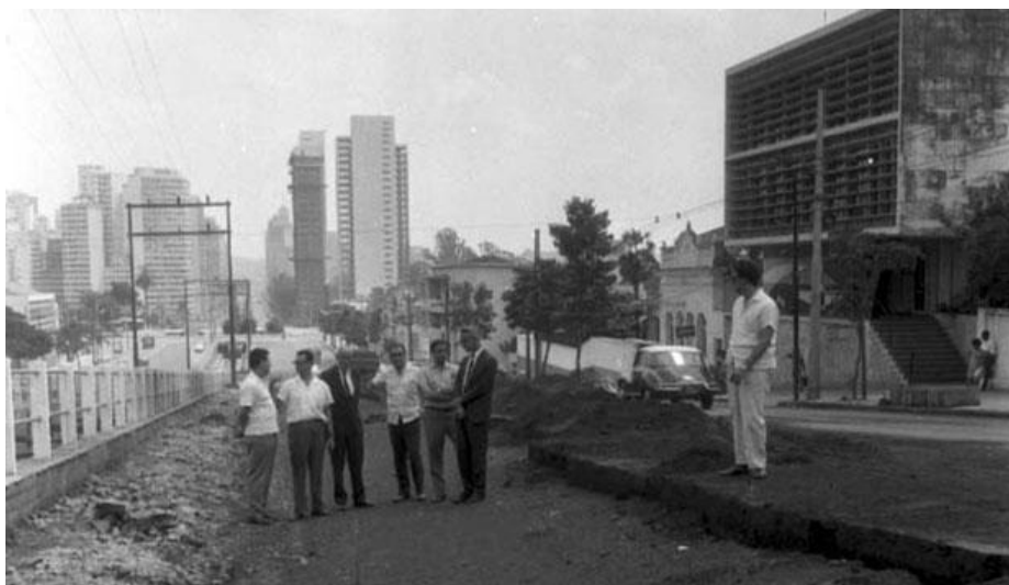
Figura 74 – Obras no Córrego do Acaba Mundo no eixo da Av. Afonso Pena (década de 1960) – À direita prédio do DOPS
