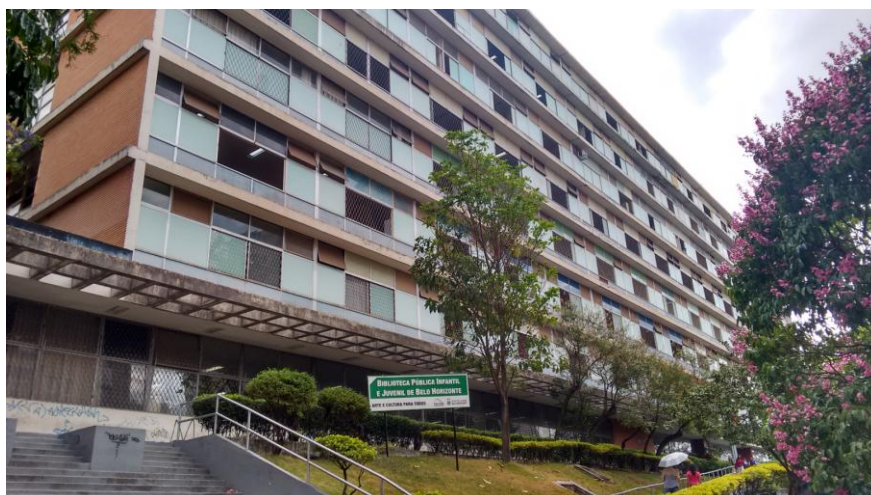
Figura 65 – Prédio da antiga FAFICH
