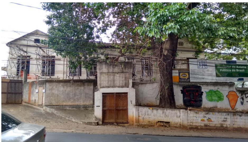
Figura 68 – Fachada em obras do “coleginho” – Memorial da Anistia
