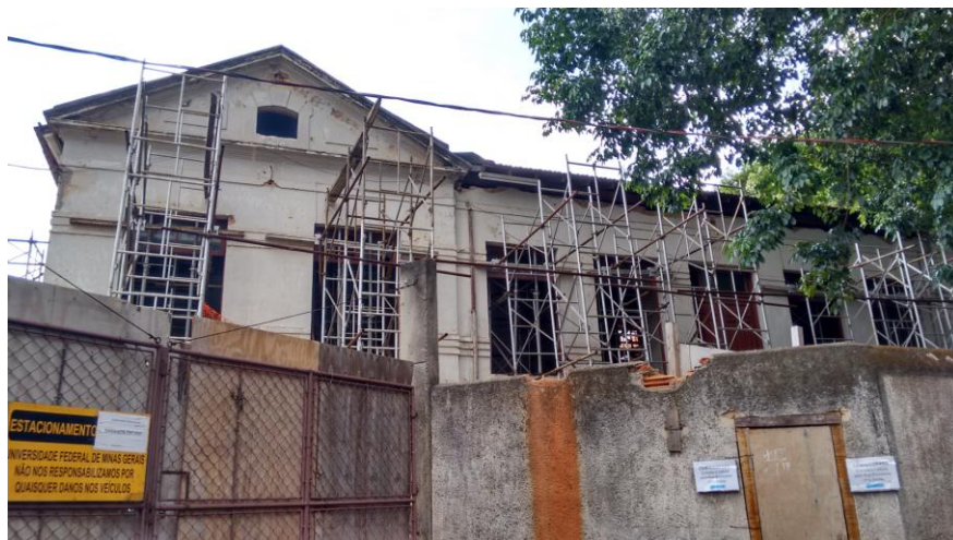
Figura 70 – Fachada em obras do “coleginho” – Memorial da Anistia
