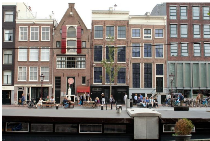
Figura 37 – Fachada do Museu Casa de Anne Frank - Amsterdã
