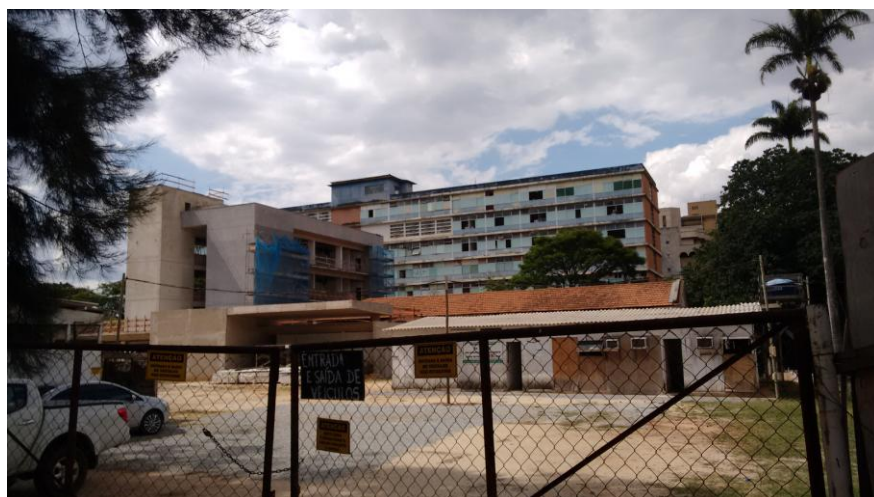
Figura 71 – Vista lateral do pátio em obras - Memorial da Anistia
