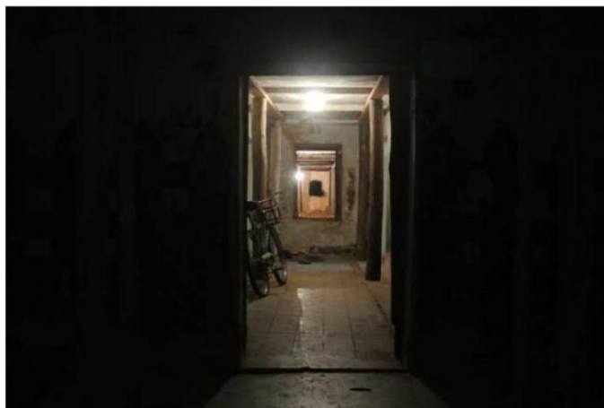
Figura 88 – Corredor com abertura para o porão ao fundo
