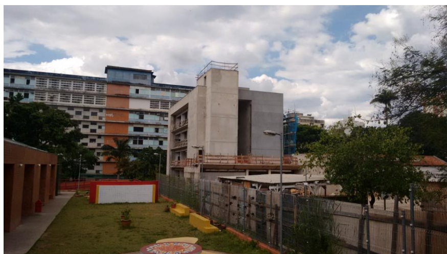
Figura 72 – Vista do anexo em obras – Memorial da Anistia
