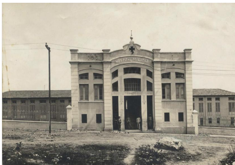
Figura 86 – Fachada do Hospital da Força Pública de Minas Gerais
