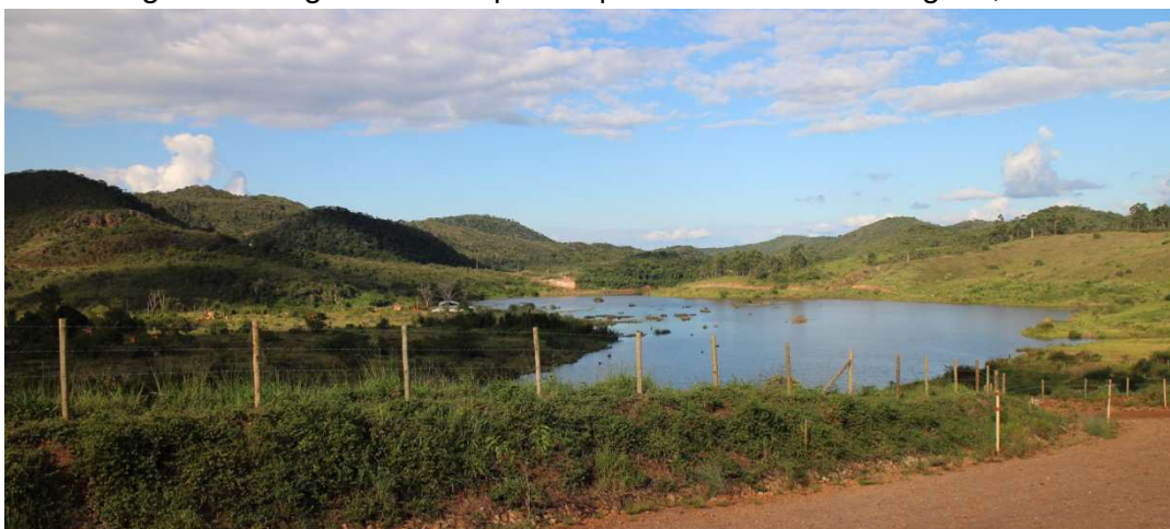
Figura 06: Lagoa formada pelo dique S4 em Bento Rodrigues, MG.
