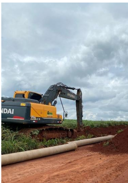
Figura 19 – Tubulação de PRFV para transporte de vinhaça em construção. (Figura do autor)
