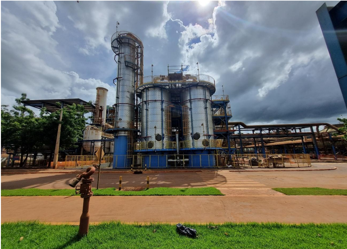
Figura A-9 – Dois vasos carregados com zeólitas para realização do processo de adsorção e uma coluna de retificação (a esquerda) para a produção de etanol anidro em uma usina de açúcar e álcool. (Figura do autor)
