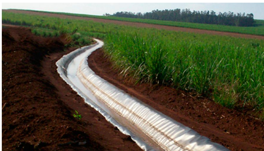
Figura 18 – Canal de transporte de vinhaça impermeabilizado com PEAD. (SILVEIRA, 2016).
