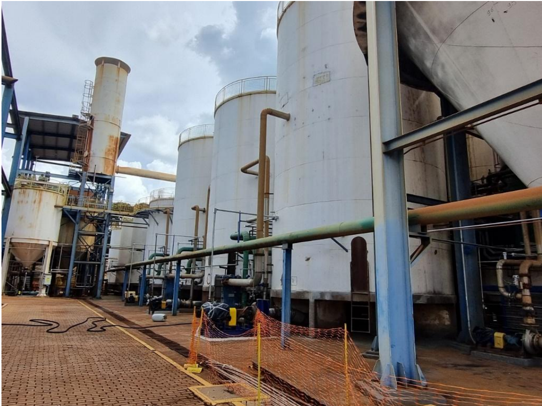
Figura A-7 – Dornas de fermentação do tipo contínuo em uma usina de açúcar e álcool. (Figura do autor)
