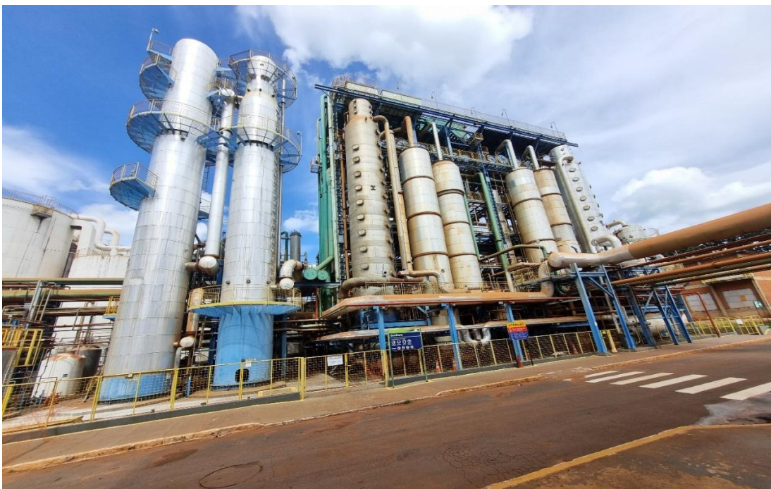
Figura A-8 – Três aparelhos de destilação de vinho em uma usina de açúcar e álcool. (Figura do autor)
