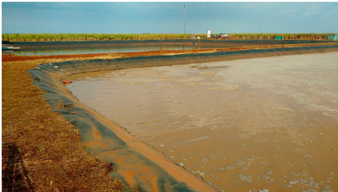
Figura 17 – Tanques de armazenamento de vinhaça. (SILVEIRA, 2016).
