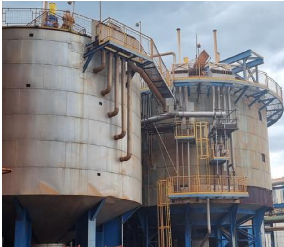
Figura A-3 – Decantadores de caldo misto de uma usina sucroenergética. (Figura do autor)
