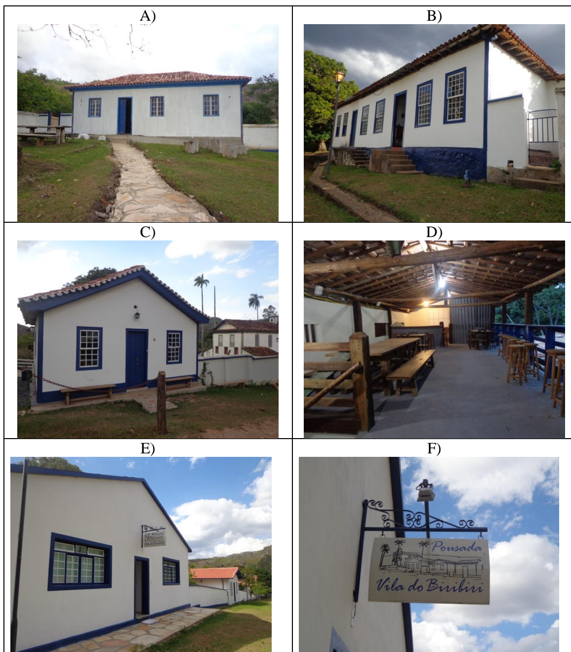
Figura 42 - Residências reformadas ou em processo de reforma - Vila do Biribiri
