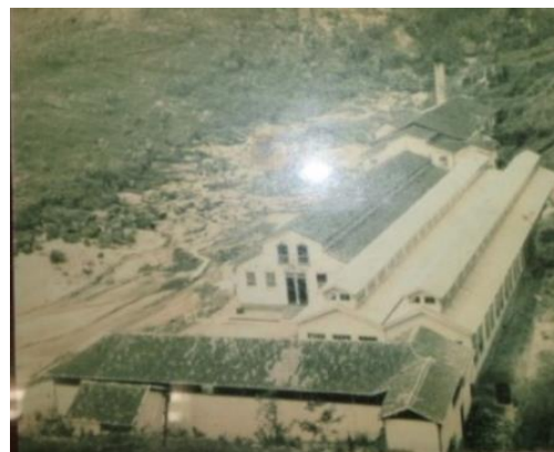
Figura 26 - Imagem dos antigos galpões de tecelagem
