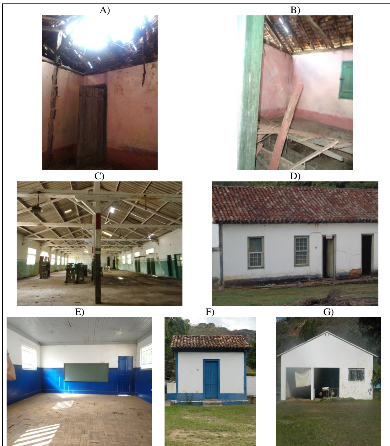
Figura 41 - Residências não reformadas ou sem uso- Vila do Biribiri
