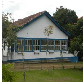
Casa da Gerência Edifício 19
