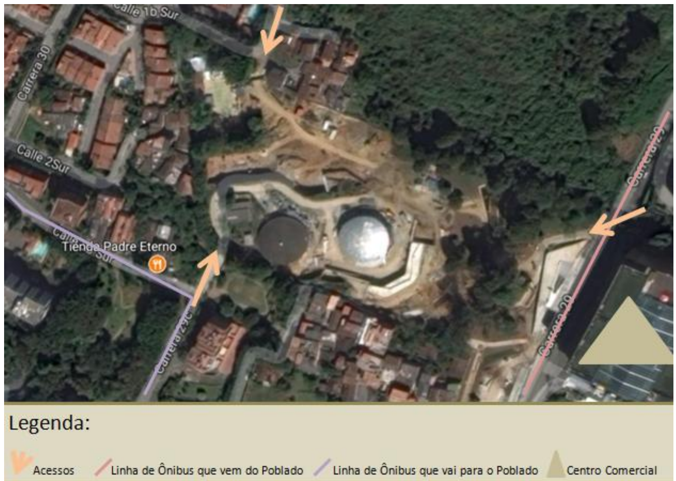
Figura 19 – Tanques Los Parras localizados no bairro Los Naranjos antes das obras da UVA. Fonte: Foto - Google Maps, edição do autor.
