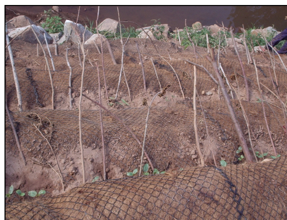
Figuras 5.13 e 5.14 – Detalhe da implantação da proteção na margem direita do rio das Velhas – Solo envelopado verde com base de enrocamento.
