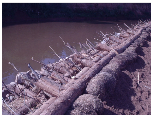
Figuras 5.13 e 5.14 – Detalhe da implantação da proteção na margem direita do rio das Velhas – Solo envelopado verde com base de enrocamento.
