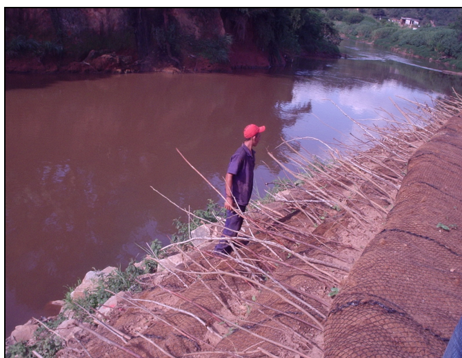
Figuras 5.11 e 5.12 – Detalhe da implantação da proteção na margem direita do rio das Velhas – Solo envelopado verde com base de enrocamento.
