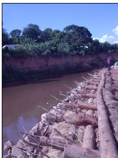
Figuras 5.11 e 5.12 – Detalhe da implantação da proteção na margem direita do rio das Velhas – Solo envelopado verde com base de enrocamento.
