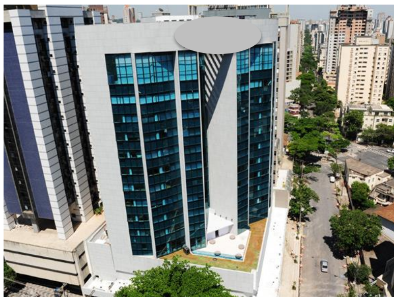
Figura 15 – Fachada L do Edifício III. Fonte: Administradora do edifício.
