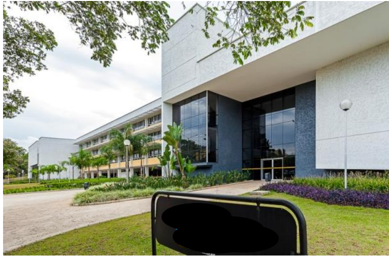
Figura 13 – Fachada SE do Edifício II. Fonte Acervo pessoal.
