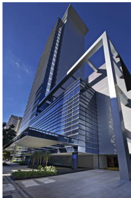
Figura 17 – Fachada N do Edifício IV. Fonte: Construtora.
