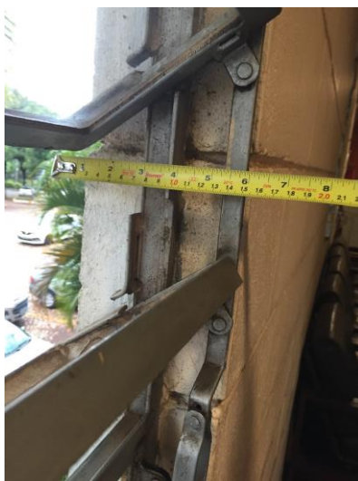
Figura 18 – Medição da espessura da parede externa do Edifício I.
