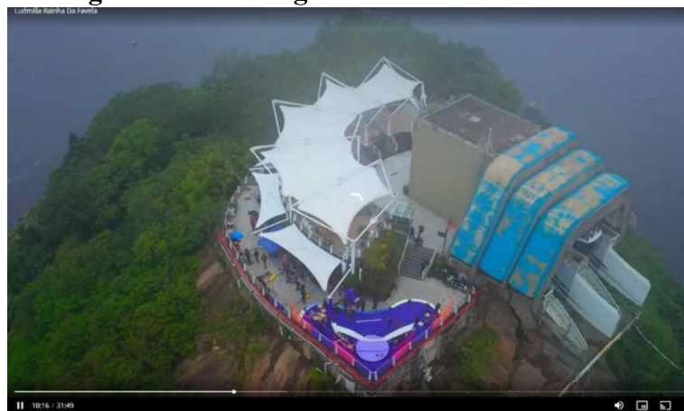
Figura 27 – Montagem do Palco “Numanice 1”
