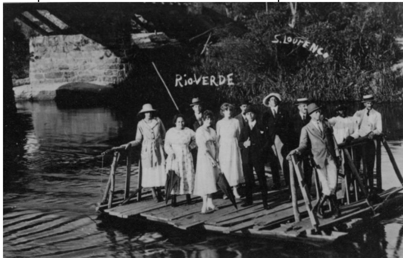
Figura 22 – Aquáticos na travessia do Rio Verde com a ponte ao fundo em construção.
