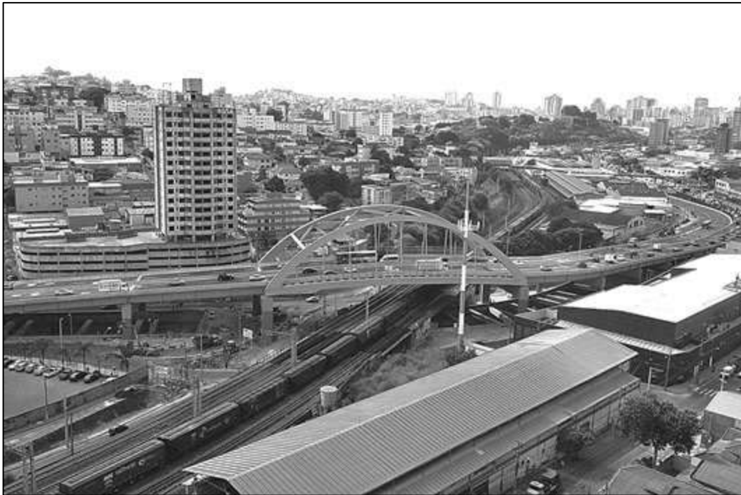
FIGURA 25 - Viaduto do Boulevard Arrudas V que transpõe a linha férrea FONTE: Site PBH
