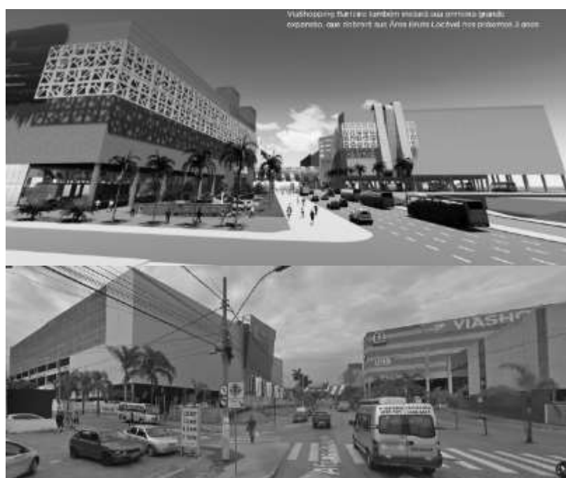
FIGURA 34 - Projeto de expansão e situação atual do Via Shopping FONTE: Site do Via shopping e vista da rua a partir do Google Earth
