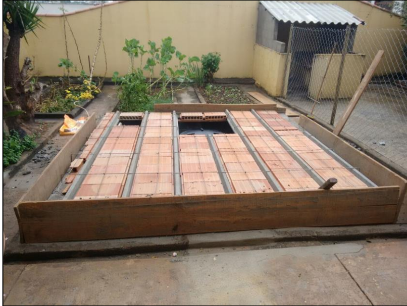
Figura 3 – Laje sendo construída para proteção do reservatório
