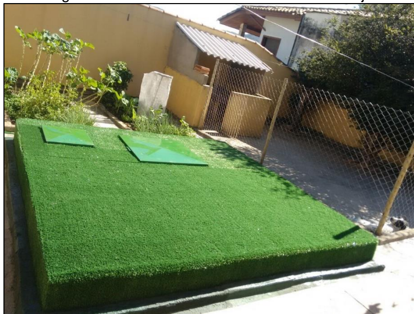
Figura 6 – Grama sintética colocada sobre a laje
