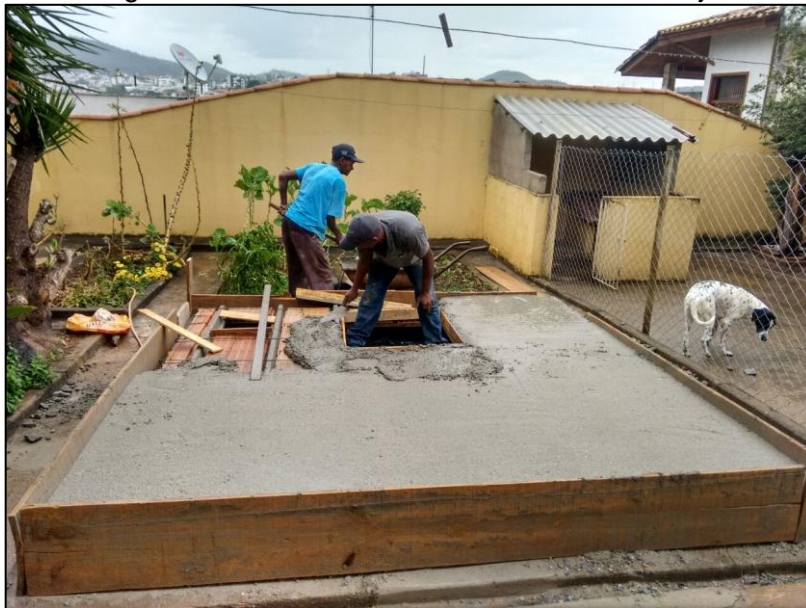
Figura 4 – Pedreiro e servente finalizando a laje
