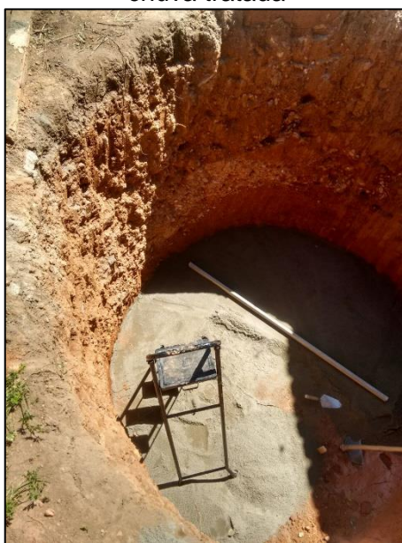
Figura 2 – Habitáculo construído para instalação do reservatório para armazenar a água da chuva tratada
