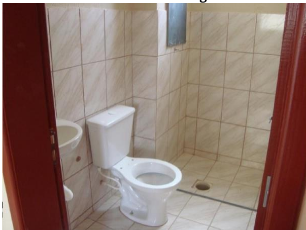
FIGURA 16–Foto interna do apartamento(banheiro), Residencial Vista Alegre
