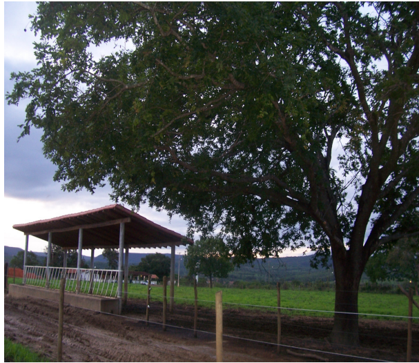
FIGURA 1 - Vista lateral do galpão meia água e o sombreamento natural do piquete na Fazenda Experimental Fonte: Elaborada pela autora. 2010.
