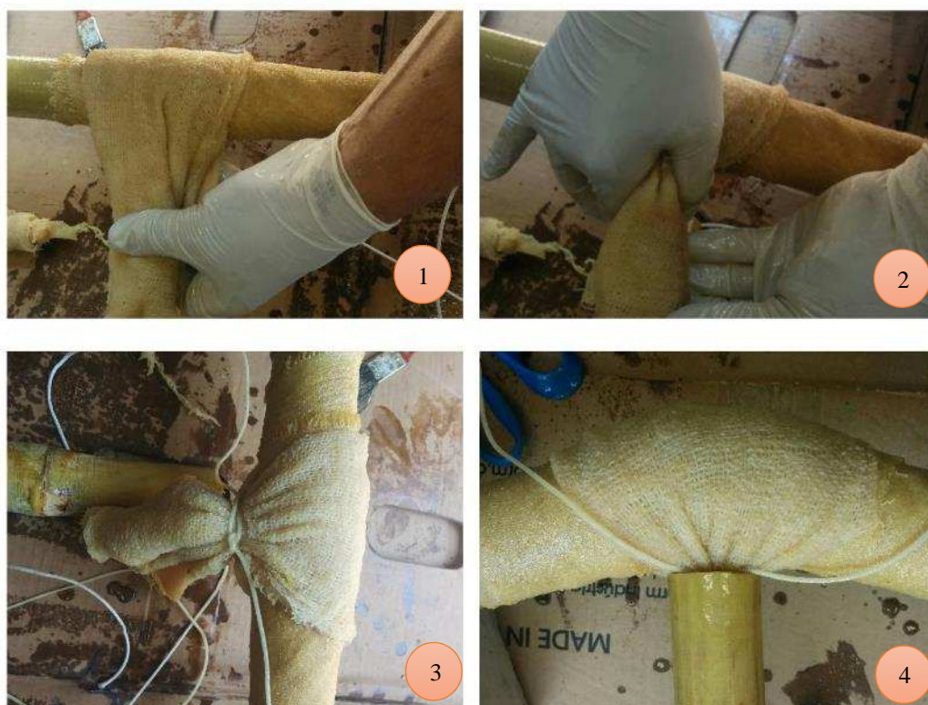
Figura 4.16: Conexão das barras internas. (Arquivo pessoal da Autora)
