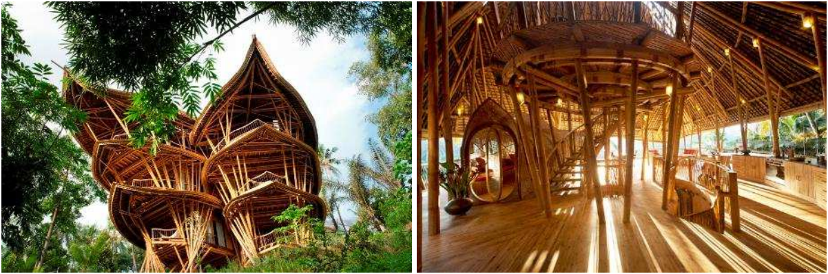
Figura 2.16: Residências de bambu, Bali - Indonésia. ( http://ibuku.com/portfolio/architecture/ )
