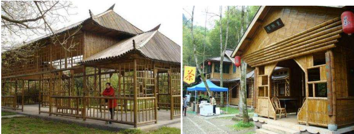
Figura 2.11: Estruturas e paredes de bambu em casas Chinesas.
