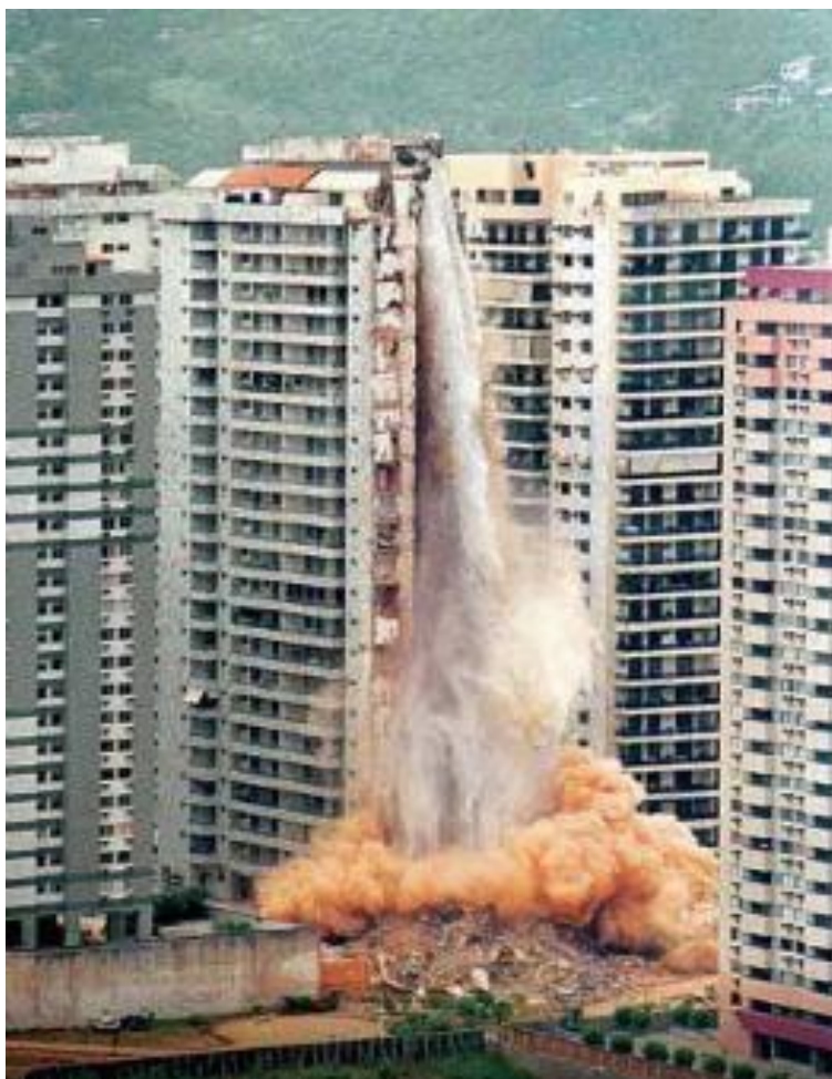
Figura 4 - Prédio em desabamento no Rio de Janeiro, decorrente de más práticas construtivas e materiais de baixa qualidade utilizados.
