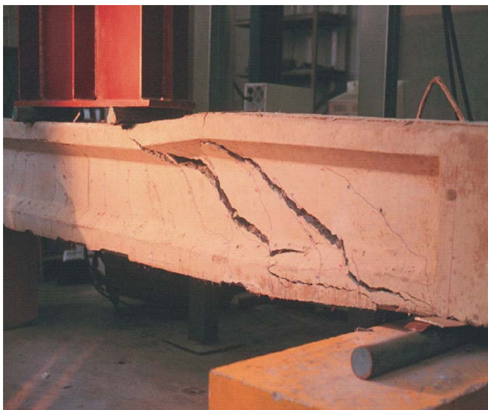
Foto 5.2 – Viga V7B – Detalhes da viga após a ruptura
