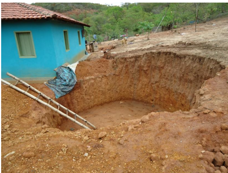
Figura 19: Processo de construção de cisternas coletoras de água de chuva em Córrego do Paiol. Fonte: MINÉ.G.O. Novembro de 2011.
