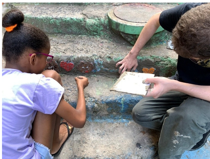
Figura 6 — Ação de UT, instalação de mosaicos no Beco São Jorge
