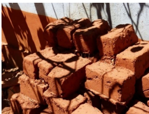
Figura 7 - Alvenaria de adobe secando ao ar livre encontrada no vilarejo de Lapinha da Serra, MG, em visita de estudos feita em 2017 Fonte: Acervo da autora
