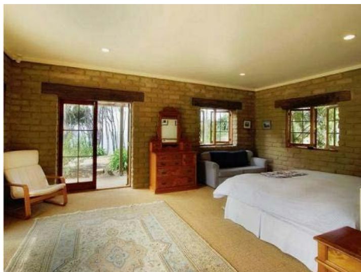
Figura 4 - Interior de residência de adobe na Nova Zelândia Fonte: SCHRODER e OGLETREE, 2010
