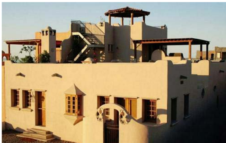
Figura 3 - Casa de alvenaria de adobe estabilizada com cal e reboco de cal em Baja California Sur, México Fonte: SCHRODER e OGLETREE, 2010
