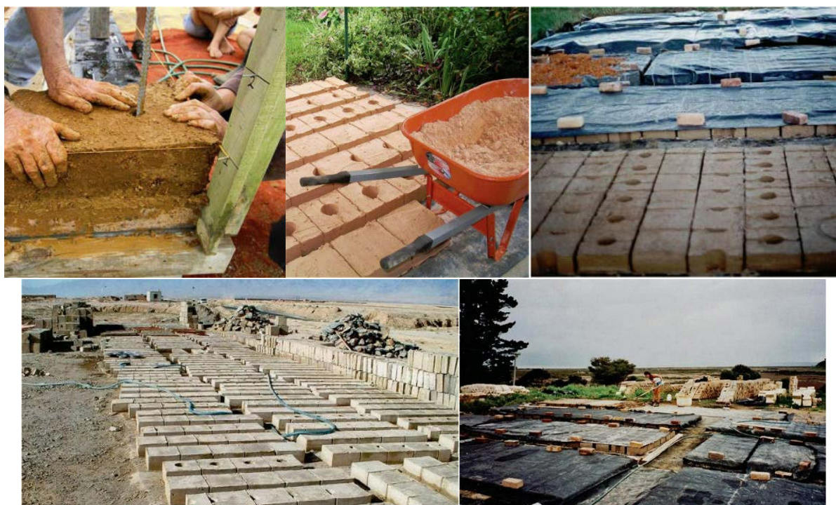
Figura 8 - Exemplos de produção, secagem e construção de adobe em diferentes escalas na Nova Zelândia Fonte: Schroder e Ogletree, 2010
