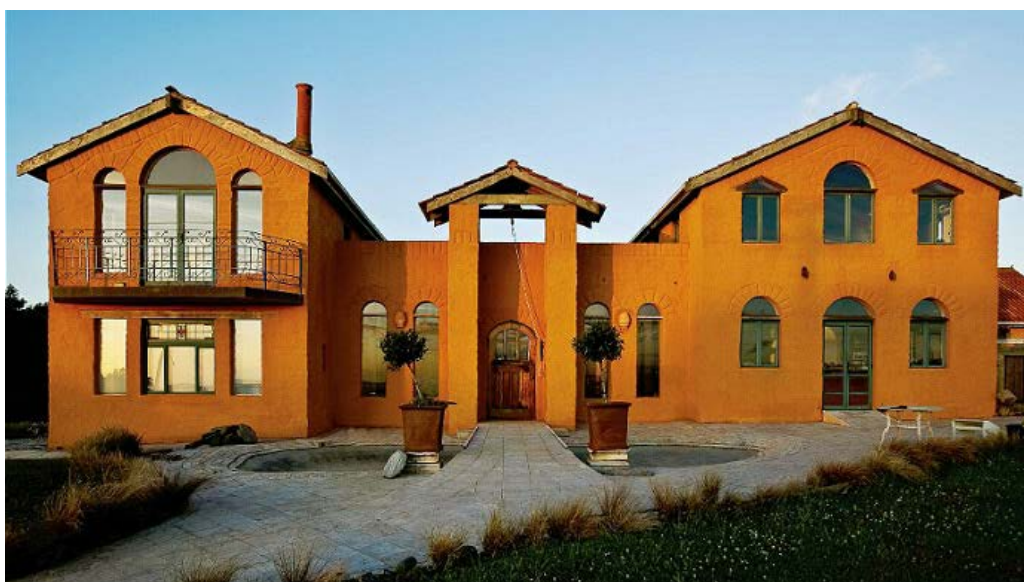
Figura 2 - Casa de adobe na ilha de Waiheke, Nova Zelândia Fonte: SCHRODER e OGLETREE, 2010
