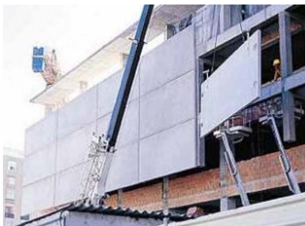
Figura 5 - Painéis arquitetônicos de GFRC (concreto reforçado com fibra de vidro) (CORBIOLLI, 2001).
