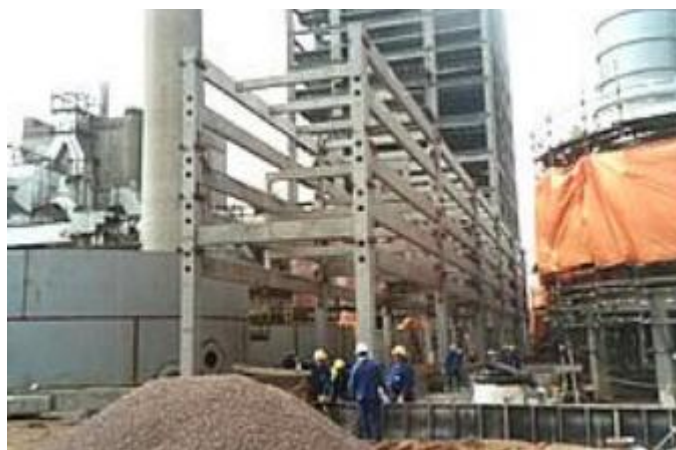
Figura 3 - Detalhe de construção pré-fabricada em ambiente industrial (ABIC, 2005).
