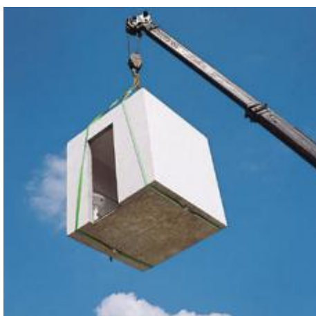
Figura 4 - Detalhe de içamento do banheiro pré-fabricado (CORBIOLLI, 2001).
