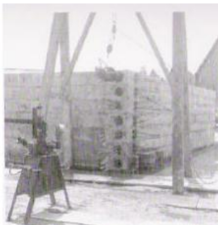
Figura 1 - Peças pré-fabricadas separadas por papel parafinado (VASCONCELOS, 2002).
