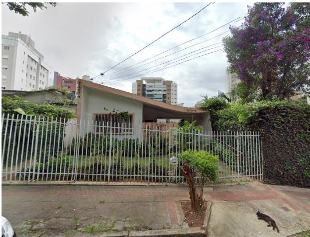
Figura 60 – Residência situada na Rua Alumínio, nº 157, Bairro Serra
