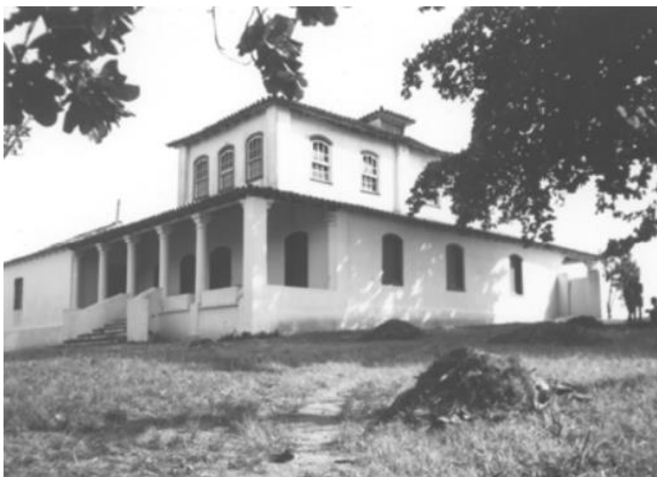
Figura 14 - Fazenda do Engenho d'Água construída no século XVIII. Jacarepaguá – RJ. Alpendre frontal
