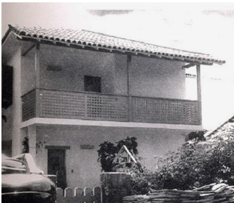
Figura 54 – Residência situada na Rua Caldas, nº 47, bairro Carmo
