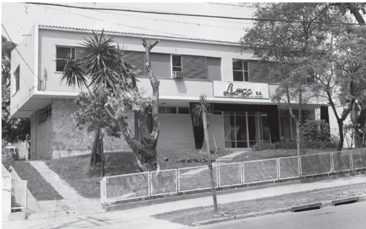
Figura 55 – Residência na Avenida do Contorno, nº. 7871, Belo Horizonte - MG
