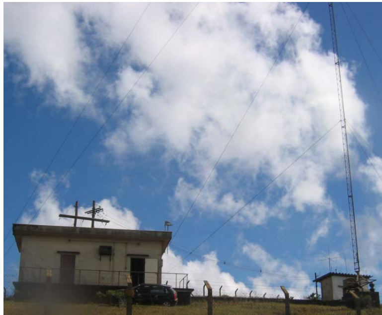
Figura 6.1 - Estação Morro do Cachimbo com torre de 60 m de altura.
