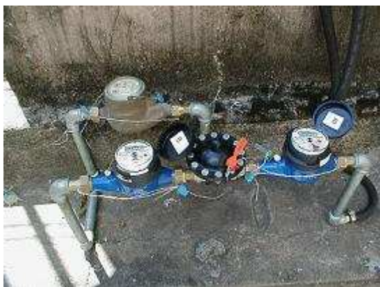
Figura 3.11- Aparato de teste (COPASA, 2004)
