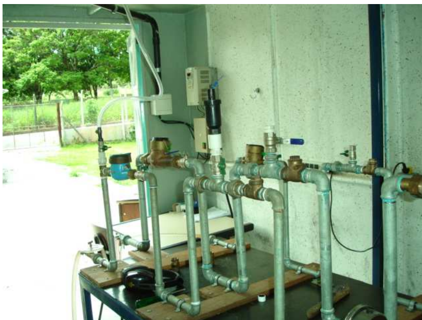
Figura 4.5- Vista interna do LEVR-AR- montagem dos cavaletes conforme padrão COPASA.
