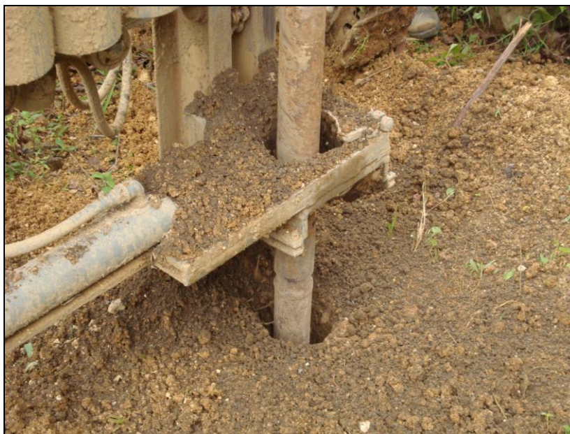
Figura 4.4: Perfuração e coleta de amostra de solo nos poços instalados.
