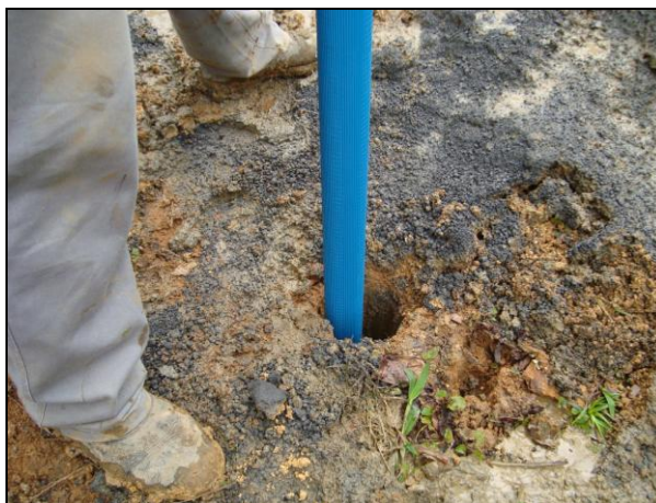
Figura 4.8: Instalação do revestimento dos poços, tubo geomecânico.
