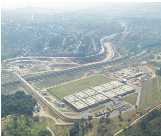
Figura 3.1 - Vista aérea da ETE Onça. Tratamento Primário (Fonte: BARBOSA, 2009)
