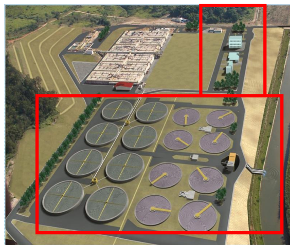
Figura 3.2 - Tratamento Secundário, desenho da unidade em construção (Fonte: BARBOSA, 2009)
