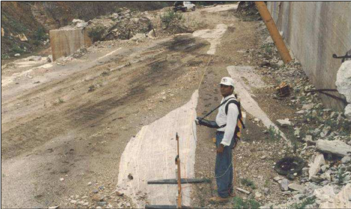
Foto 6.5: Local de execução do perfil 11 e equipamento GPR .
