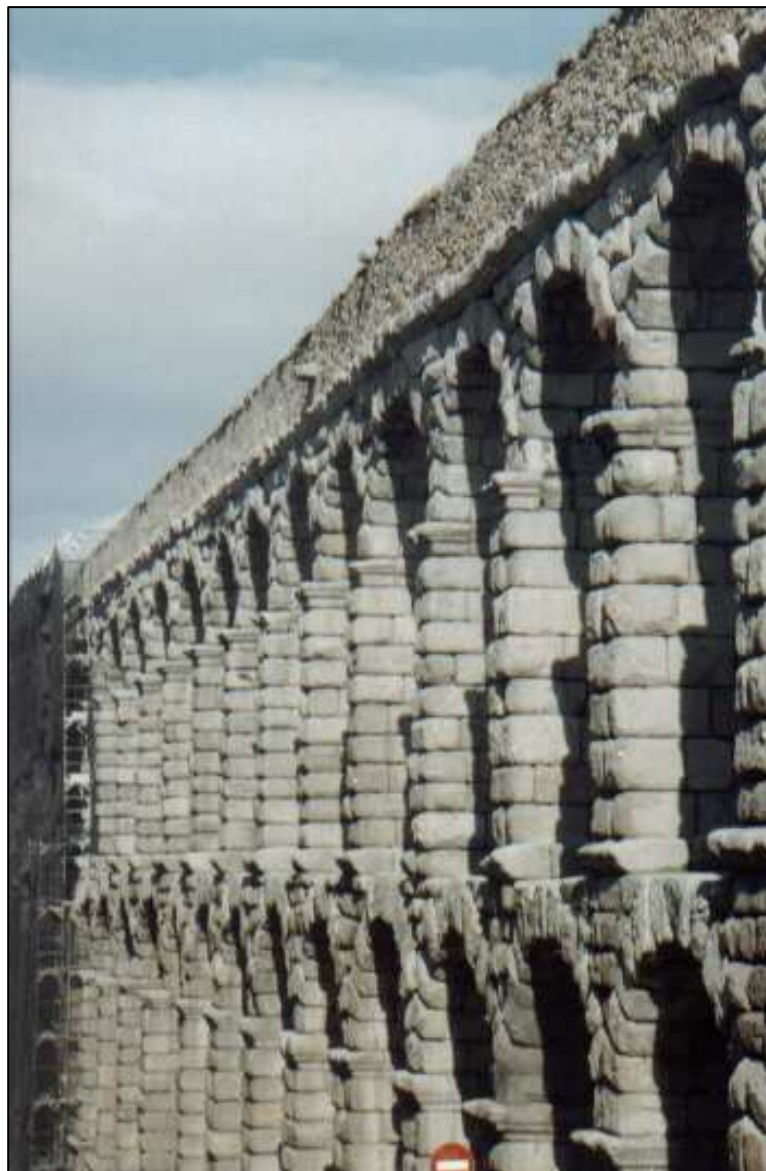
Foto 3.1: Aqueduto romano em Segóvia (Espanha), construído em blocos de granito encaixados há 2.000 anos.
