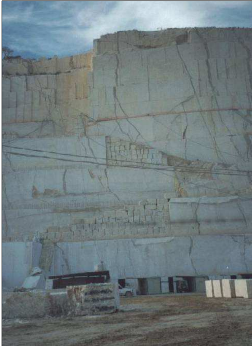
Foto 3.2: Lavra desenvolvida em degraus múltiplos curtos em Alicante – Espanha.
