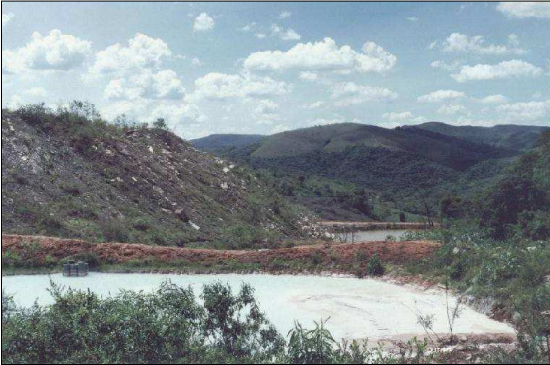
Foto 5.7: Barragens primária e secundária (vista em segundo plano) de retenção de finos provenientes do processo de beneficiamento.
