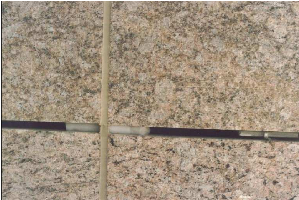
Foto 3.14: Conjunto de inserts na parte inferior de placa pétrea, mostrando ainda o suporte impermeabilizado.
