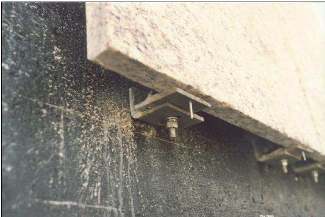
Foto 3.14: Conjunto de inserts na parte inferior de placa pétrea, mostrando ainda o suporte impermeabilizado.
