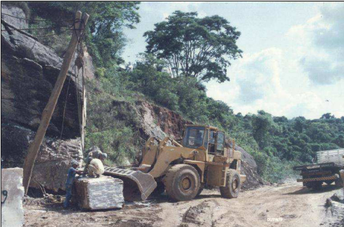
Foto 5.3: Carregamento de bloco em “pau de carga”.
